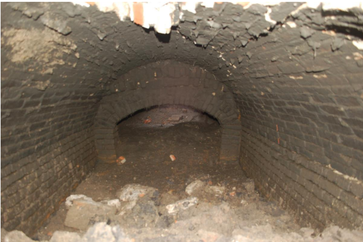
Figuur 15: Zicht vanuit het noorden op de binnenzijde van het intacte zuidelijke deel van de ondergrondse structuur. Achter een bakstenen boog met steunberen is geen muur zichtbaar maar lichtinval vanuit de bewaarde toegangspot. Op de vloer ligt een laag slib, die geleidelijk oploopt naar het zuiden toe (achteraan op de foto).
