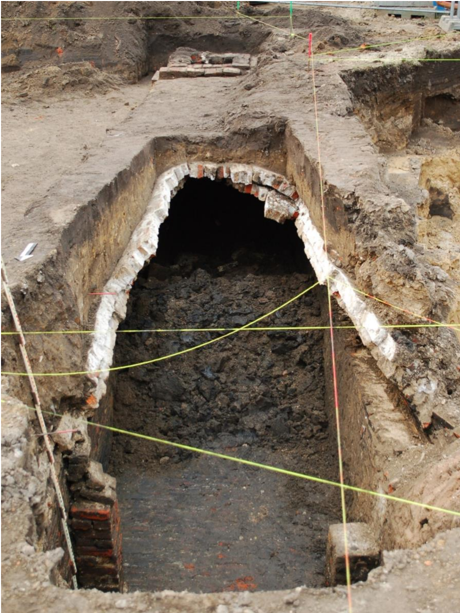
Figuur 12: Zicht vanuit het noorden op de structuur op het einde van het onderzoek. Het puin werd verwijderd uit het noordelijk uiteinde, profielen werden aangelegd op de oost- en westzijden van het ingestort gewelf, en de toegangspuit in het zuiden werd uitgegraven. Op de voorgrond is een deel van de bakstenen vloer van de structuur zichtbaar, en de restanten van twee steunberen. Bemerkt hoe de westzijde (rechts op de foto) van het tongewelf naar buiten toe verschoven is tot naast de onderliggende muur, en het onstabiele voorkomen van het uit twee baksteenlagen bestaande gewelf.
