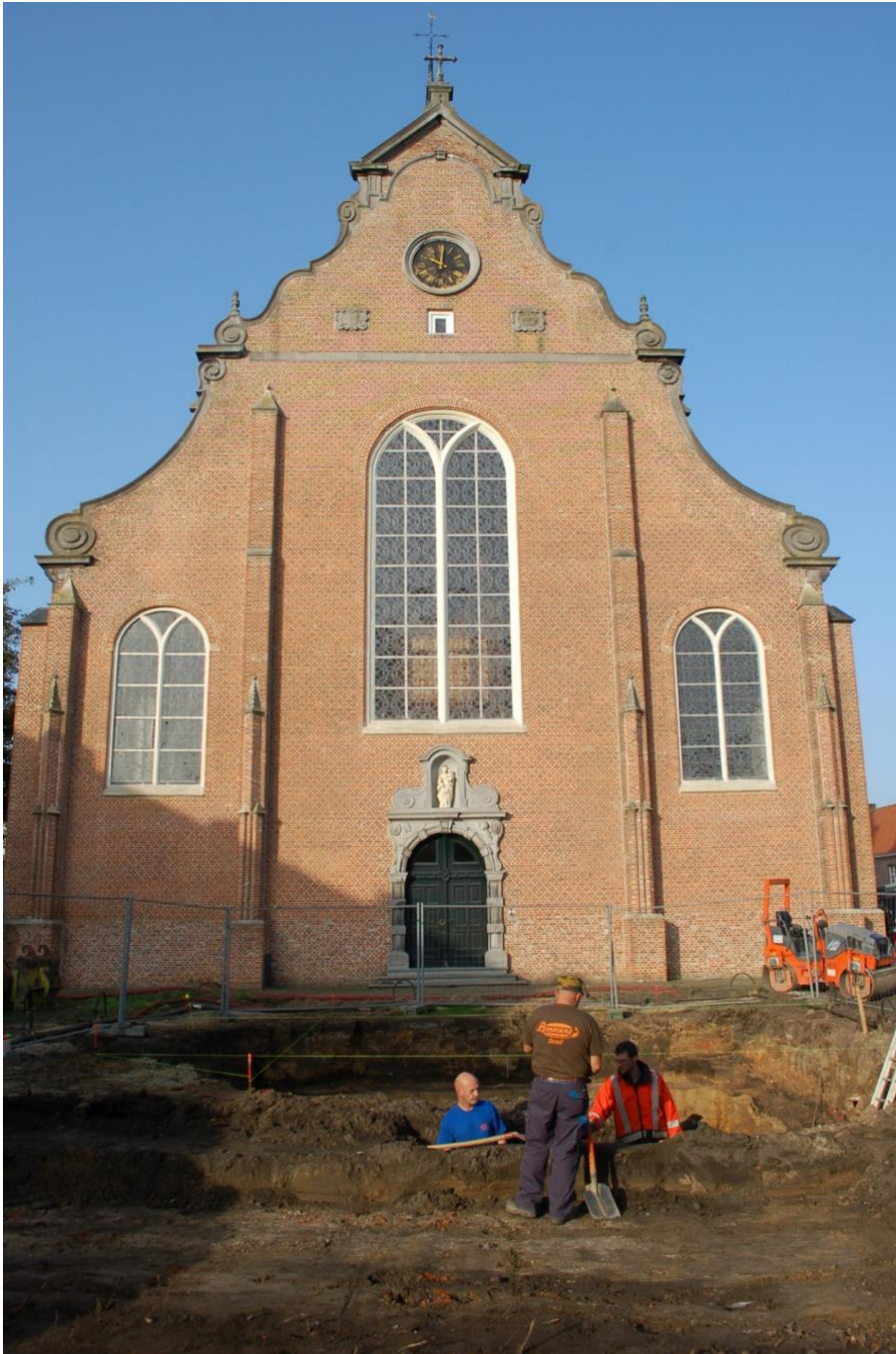
Figuur 9: Zicht vanuit het oosten op de onderzoekszone, met de begijnhofkerk op de achtergrond. Twee personen staan in het ingestorte deel van de ondergrondse structuur. De diepe put voor de aanleg van een sterfput en ondergrondse technische ruimte bevindt zich hier net achter, binnen de afrastering.
