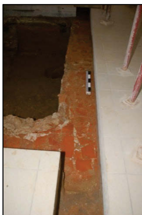
FIG. 18 De hoek tussen de muurfunderingen S1 en S2 in bovenaanzicht.
