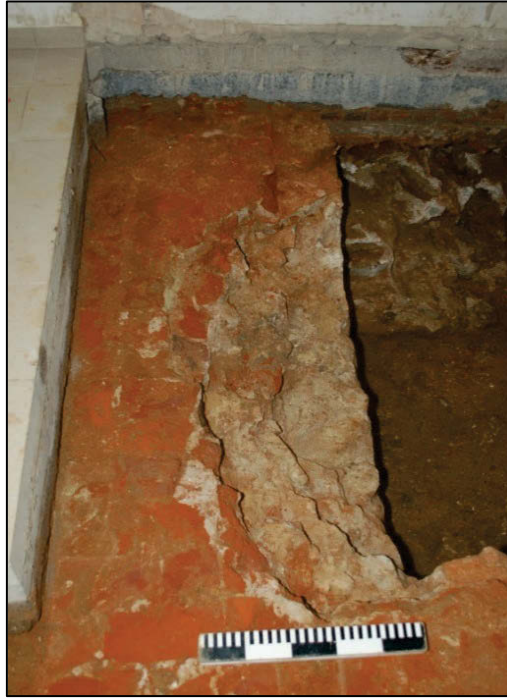
FIG. 22 De recente vloer op de muurfunderingen.
