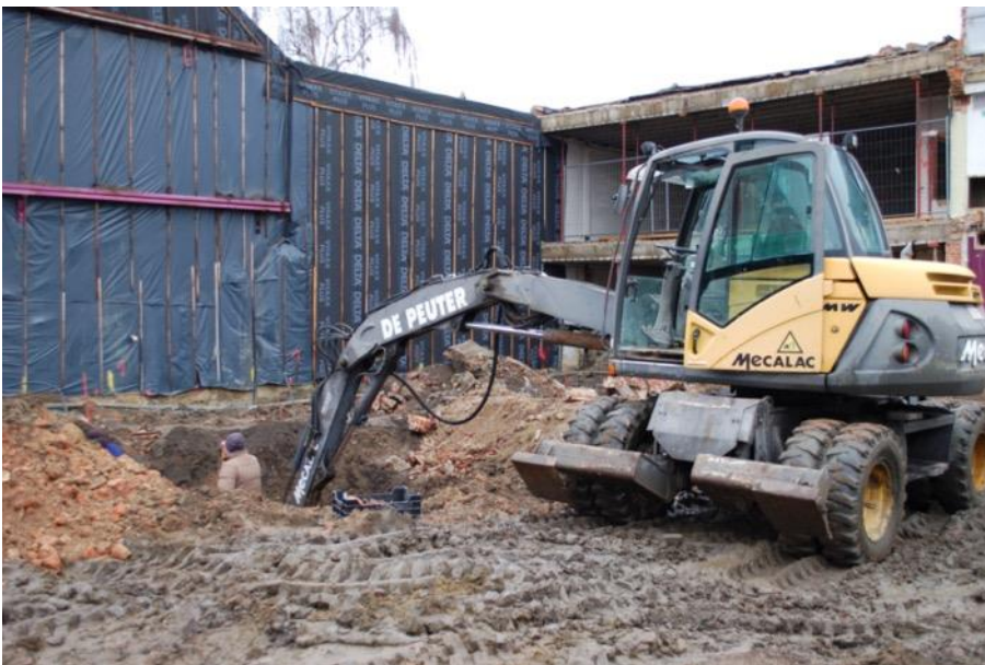
Figuur 4: Graafwerken voorafgaand aan het opschonen van de werkput en de aanwezige muurresten op 15/02/2018 (© agentschap Onroerend Erfgoed).
