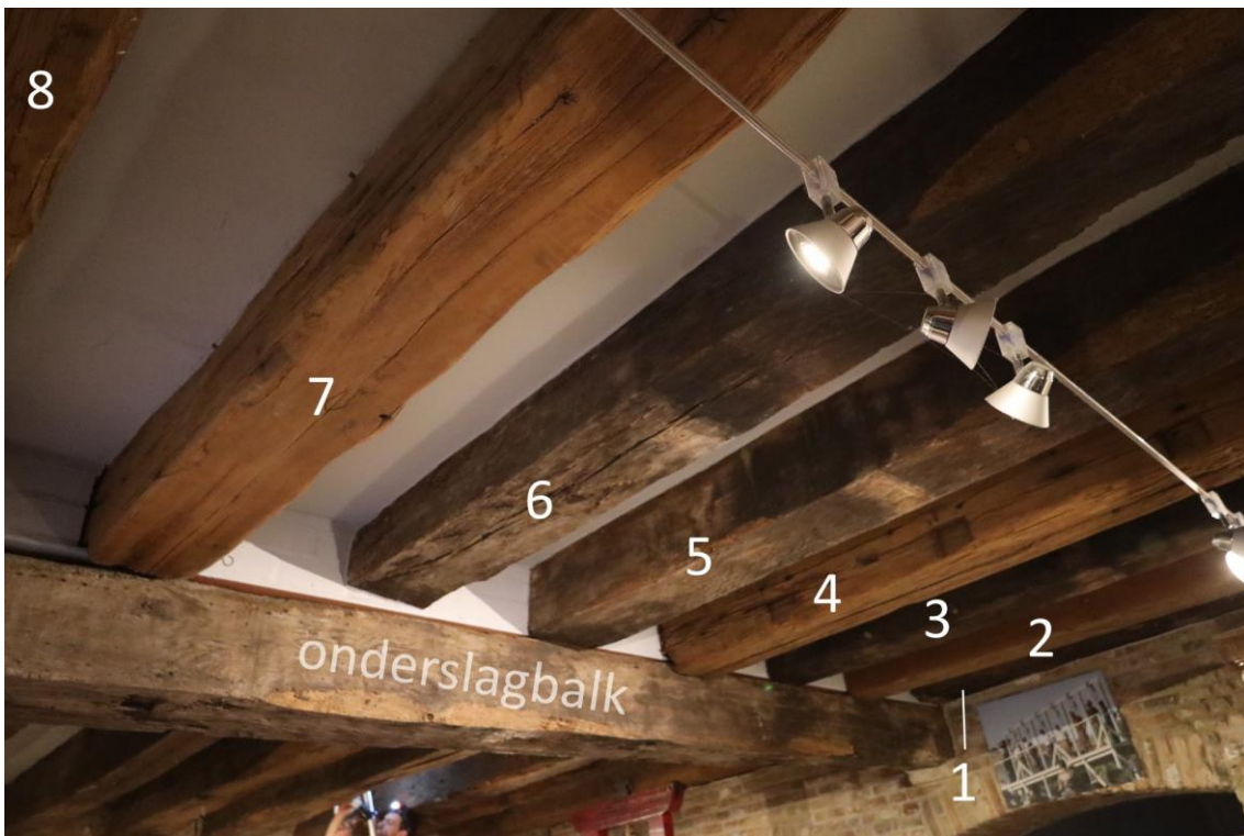
Figuur 8: Zicht naar het noordwesten op de zuidoostelijke balken en de onderslagbalk van de kelder van De Oude Steen.
