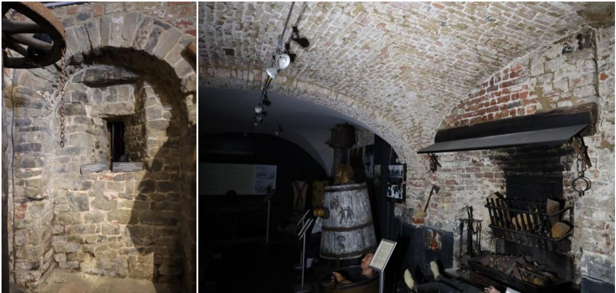
Figuur 4: Spaarboog in de zuidwestelijke kelder muur (links). Zicht op het verbouwde deel van de noordwestelijke kelder muur, met haard (rechts).
