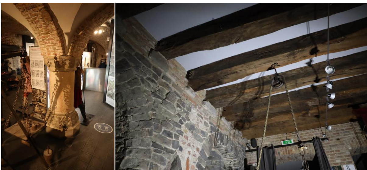
Figuur 3: Natuurstenen zuil in het zuidwestelijke deel van de kelder (links). De noordwestelijke keldermuur in veldsteen en een deel van de houten balklaag (rechts)
