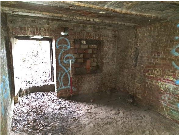
Figuur 33: Interieur van de schuilplaats, met dichtgemaakte vensteropening (foto: Sam De Decker).
