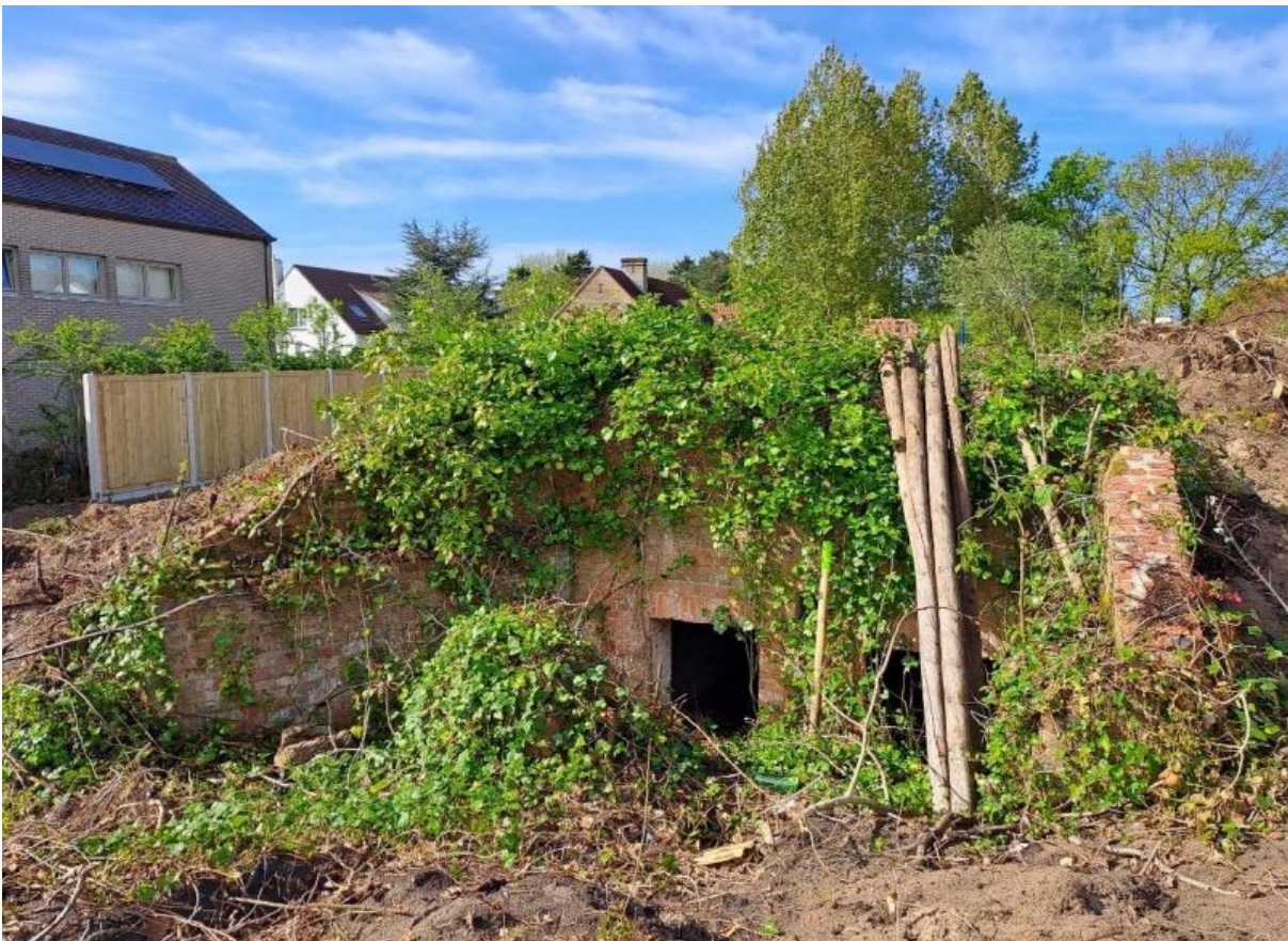
Figuur 1: Zicht op de constructie na verwijdering van bomen en struikgewas, waarna de melding werd gedaan (Foto: Alexander Lehouck, gemeente Koksijde).
