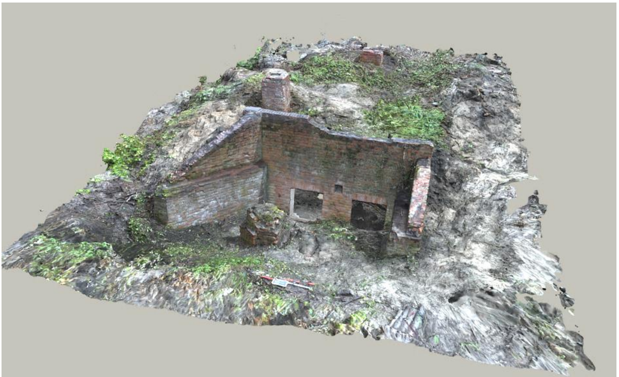
Figuur 21: 3D-terreinopname van de constructie (opname en beeld: Johan van Laecke).
