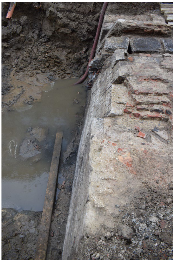
Figuur 28. Zich op de façade van de Begijnenpoort van bovenaf. De schuine helling van deze façade is hier goed te zien, evenals de zone die extra schuin loopt onder de ophaalbrug – (© Stad Antwerpen dienst archeologie).
