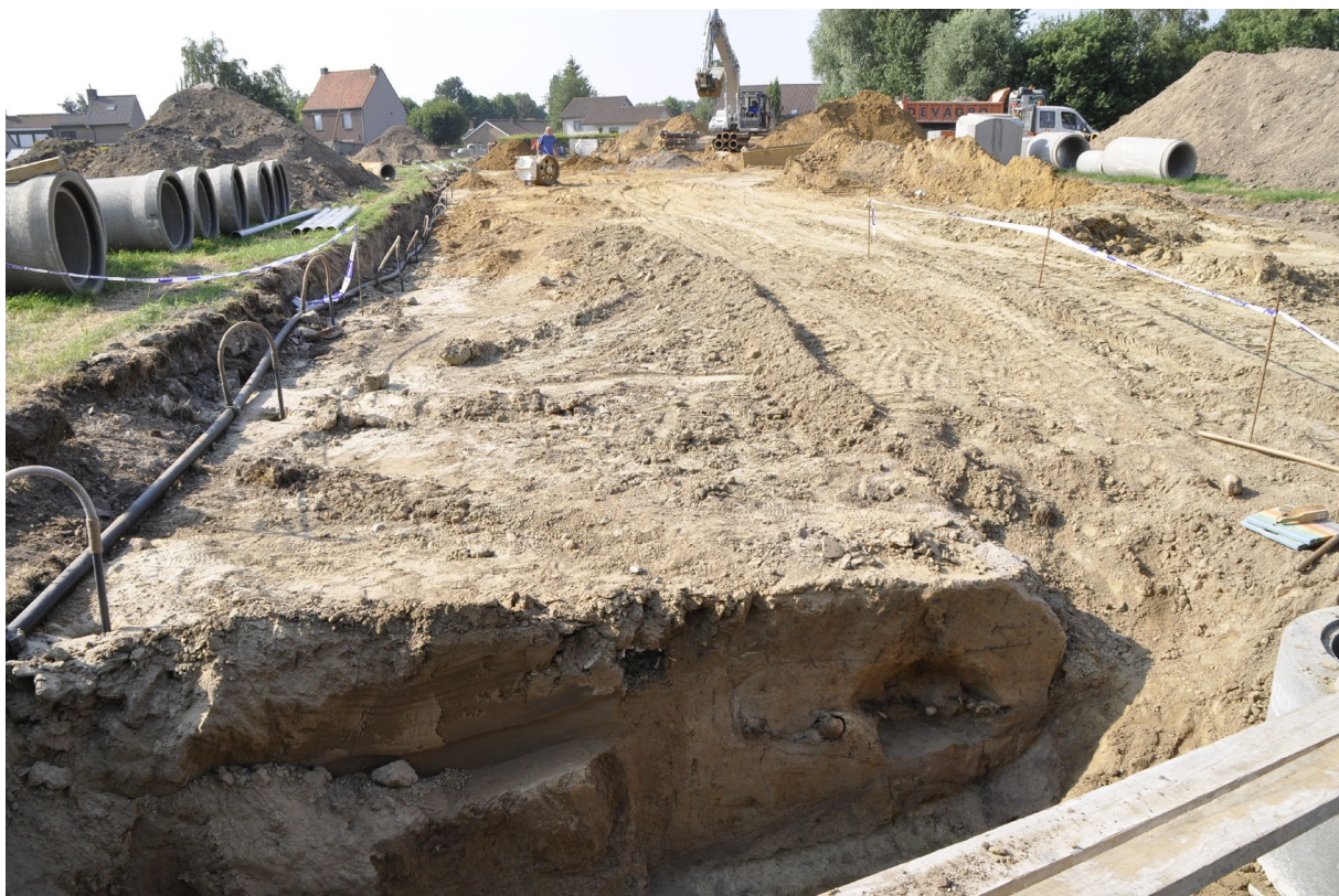
Figuur 10: Zicht vanuit het Noorden op de werkzaamheden met de aangesneden grafkuil op de voorgrond. © Onroerend Erfgoed, foto: Franky Wyffels.
