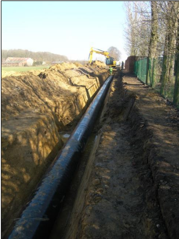
Fig. 1 Graafwerken voor een nieuwe watertoevoerleiding.
