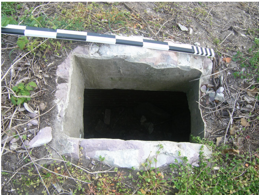
Figuur 16: Veldopname van één van de ventilatieschachten in het dak van de overdekte loopgraaf (bron: Agentschap Onroerend Erfgoed).
