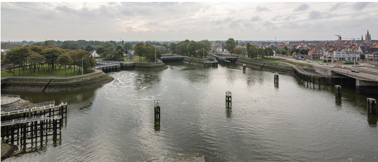
Figuur 45: Zicht op het sluizencomplex van de huidige Ganzepoot in Nieuwpoort, foto Albert Deveen, 2019, copyright: Toerisme Nieuwpoort.
