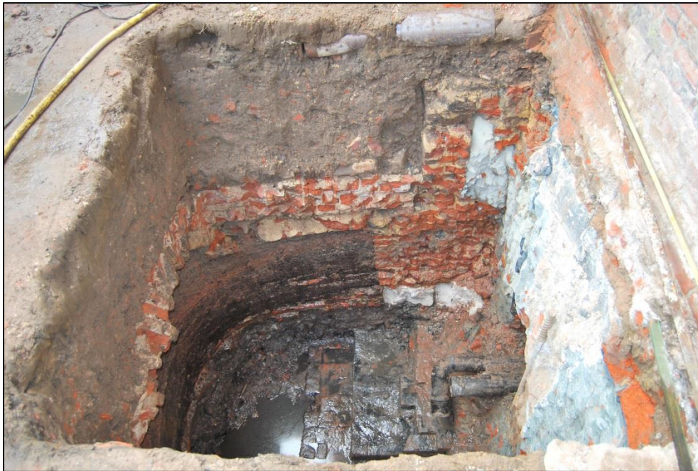
Fig. 6 Funderingsopbouw: getrapte fundering op een getrapte poer.
