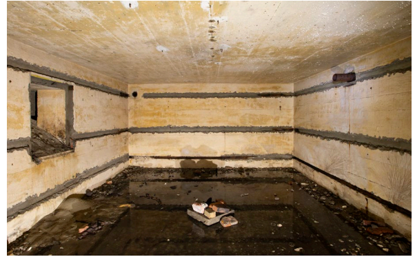
Figuur 26: Zicht op het interieur van S1. © agentschap Onroerend Erfgoed.
