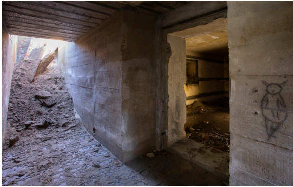
Figuur 25: De gang van S1, met zicht op de westelijke toegang en de ingang tot het feitelijke manschappenverblijf. © agentschap Onroerend Erfgoed.
