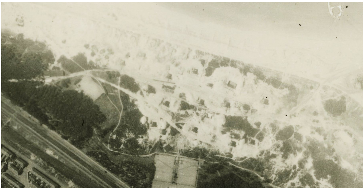
Figuur 13: Luchtfoto van 29 juni 1942, met daarop de bunkers in aanbouw te zien. ©NARAc, via Pierre Nowak.
