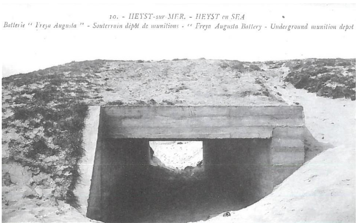
Figuur 9 Opslagbunkers voor munitie (bron: Lambrecht 2015)
