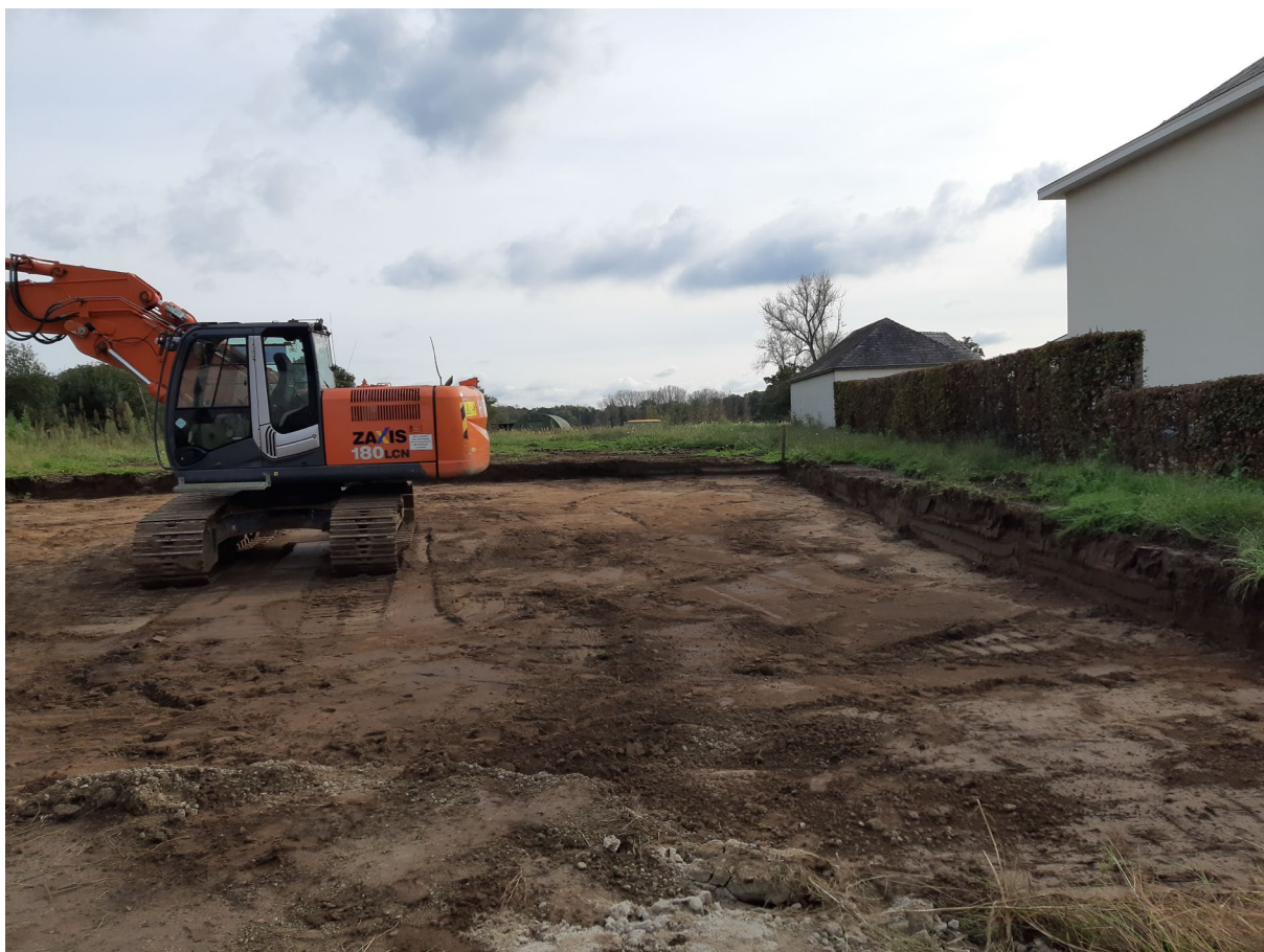
Figuur 1: Situatie bij aankomst op het terrein, voor aanvangen van het onderzoek (© Onroerend Erfgoed, foto: Niels Janssens).
