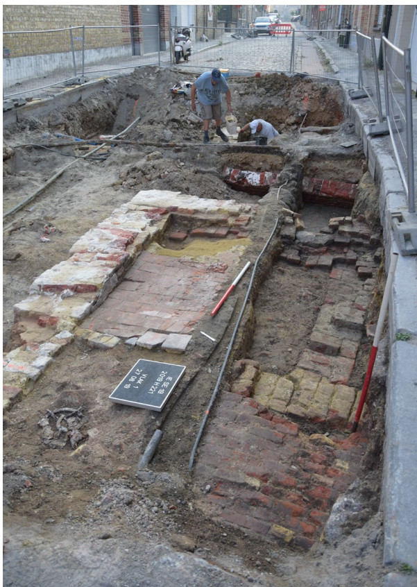
Figuur 32: De werkput naar het ONO, met het muurwerk en de vloerniveaus van vlak 1 ten zuiden van de W-O versterking, met daarachter de recente overwelling van de Schipleet. © agentschap Onroerend Erfgoed.
