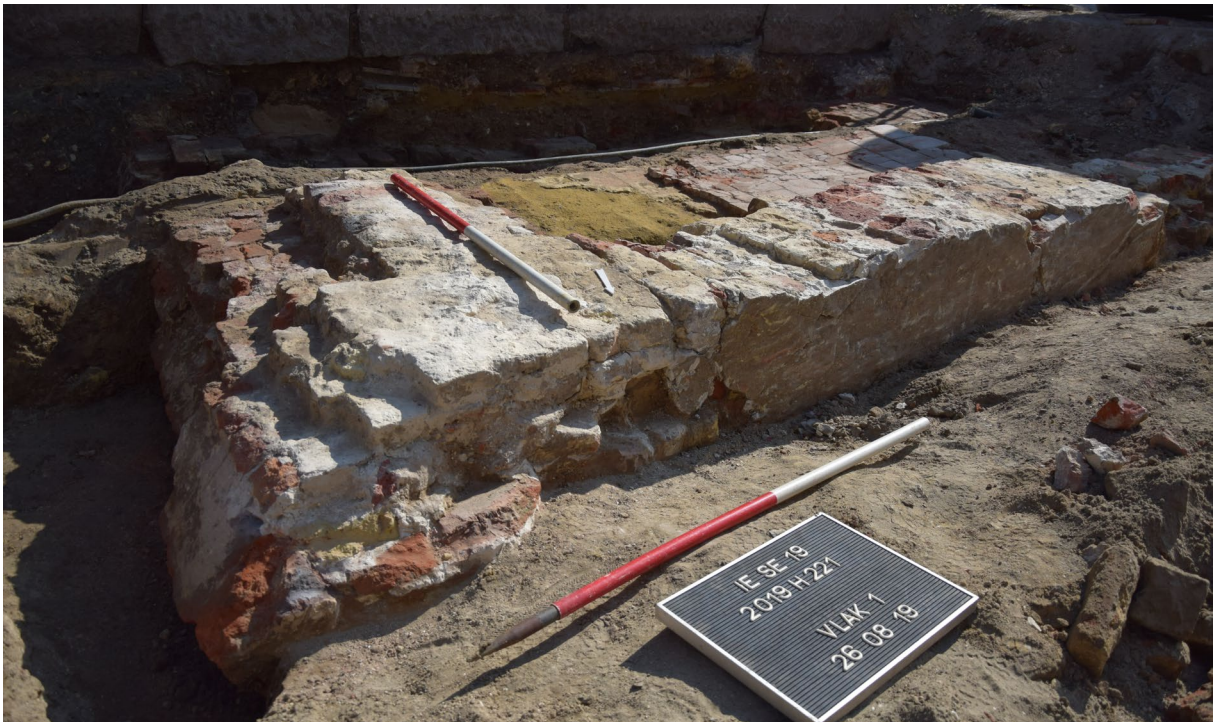
Figuur 31: De buitenzijde van muur 2, muur 12 die een hoek maakt, en het onderliggende muurwerk 14 dat (zie voorgrond) duidelijk afgebroken werd bij het plaatsen van de nutsleidingen in de 20ste eeuw. Muur 2 en de voorzijde van muur 12 zijn wit bepleisterd. Foto naar het zuiden. © agentschap Onroerend Erfgoed.
