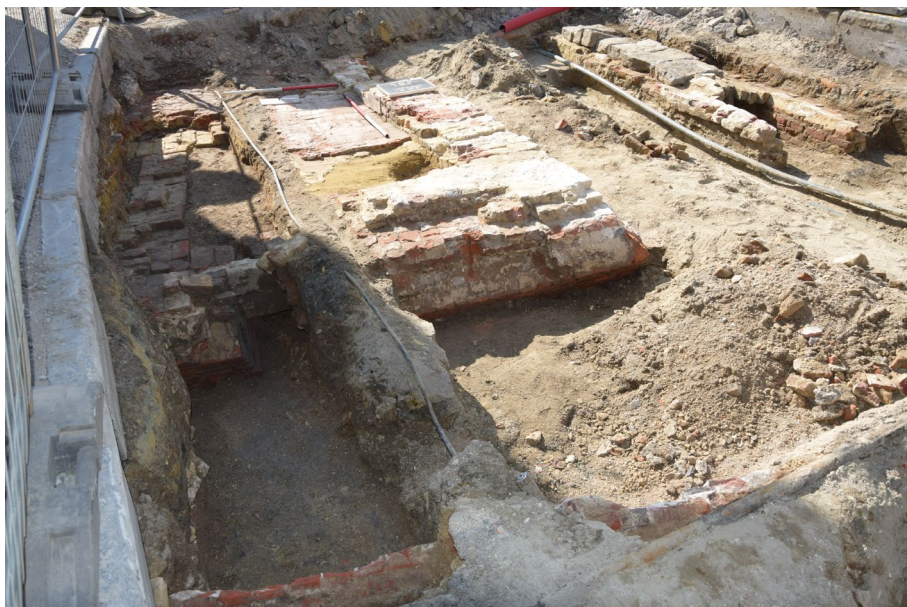
Figuur 21: Het westelijk deel van de werkput, naar het westen, met inbegrip van de ingekokerde Schipleet op de voorgrond, de bakstenen riool rechts op de achtergrond, en het muurwerk met vloerniveaus van vlak 1 links op de achtergrond, palend aan de ingekokerde Schipleet. © agentschap Onroerend Erfgoed.
