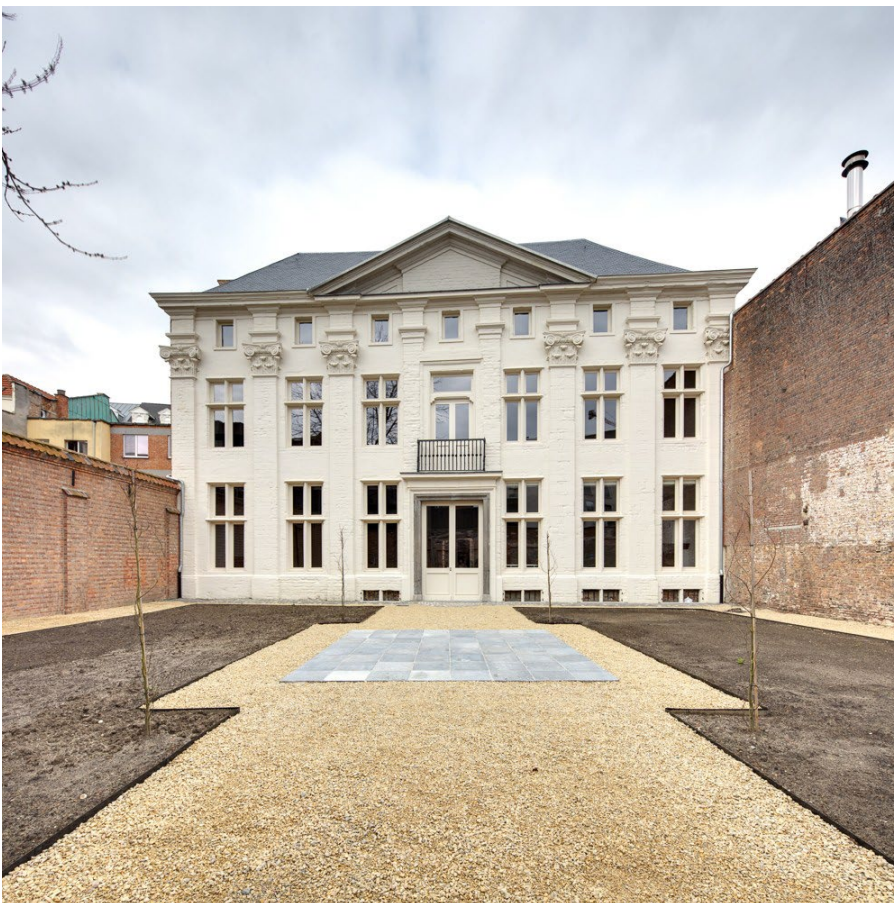
Figuur 11. De achtergevel van het Mercator-Orteliushuis na renovatie in 2023. (© AG Vespa - Bart Gosselin)
