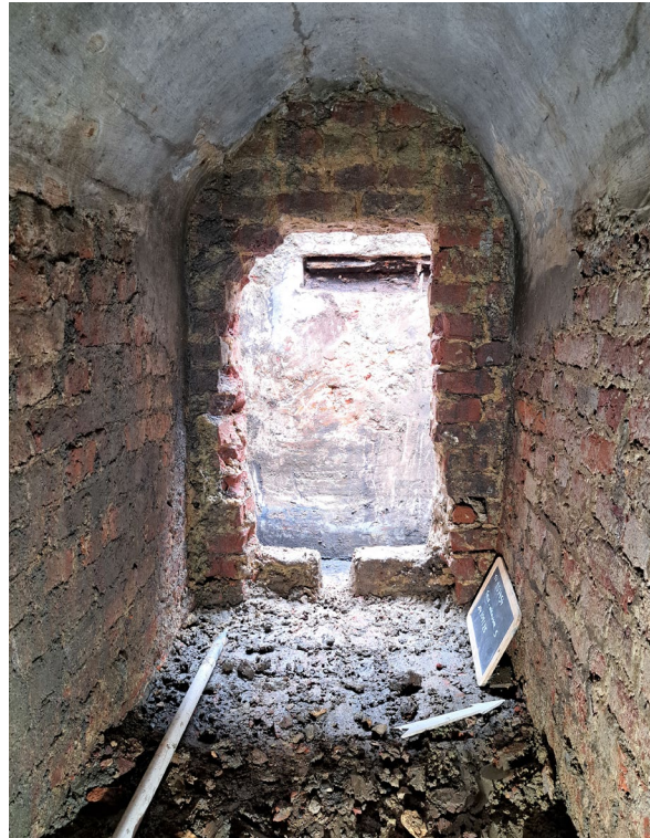
Figuur 15: Aansluiting met de verticale schacht, overzicht vanuit het zuidoosten (© agentschap Onroerend Erfgoed, foto: Sam De Decker).
