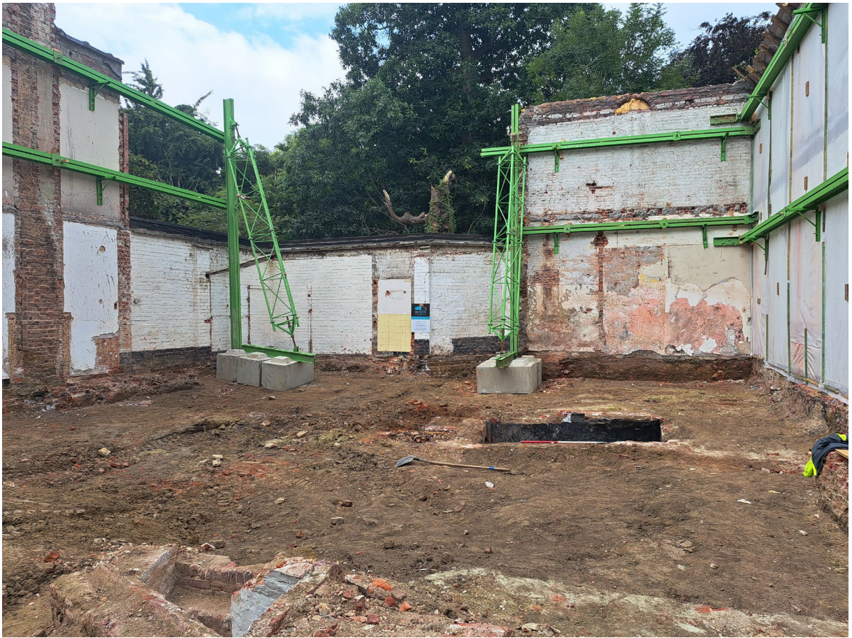
Figuur 4: De werf gezien vanop de Nieuwstraat, na sloop van de aanwezige bebouwing. Centraal is de beerput goed te zien (© agentschap Onroerend Erfgoed, foto: Sam De Decker).
