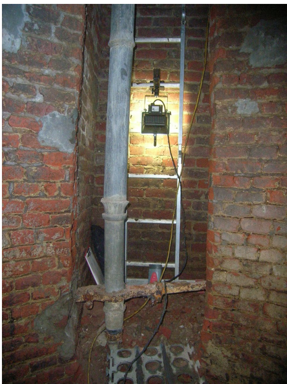
Figuur 17: Beeld uit 2017 van de schacht, met loden buis (© agentschap Onroerend Erfgoed, foto: Franky Wyffels)
