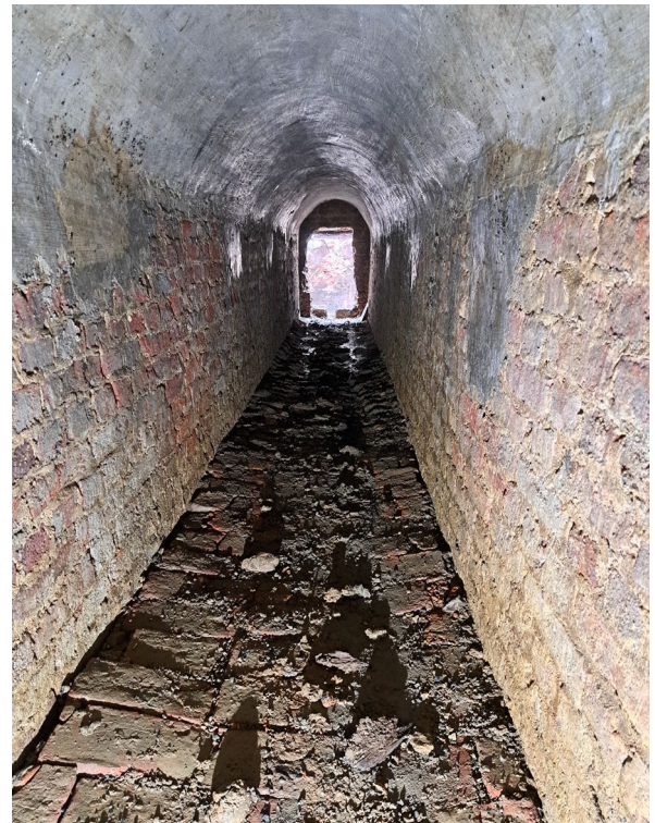
Figuur 13: Binnenzicht van de tunnel richting koetshuis, overzicht vanuit het zuidoosten (© agentschap Onroerend Erfgoed, foto: Sam De Decker).
