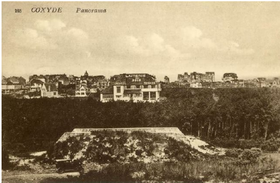
Figuur 33: Beeld uit het interbellum met zicht op restaurant 'Laiterie du Bois' dat boven op de betonconstructie van de noordelijke geschutopstelling werd gebouwd. De zuidelijke opstelling was nog goed bewaard. (Bron: Piérart 2018-2020).
