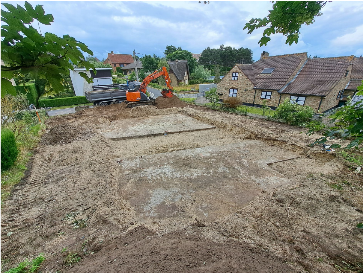
Figuur 14: Sfeerbeeld van het archeologisch onderzoek op 8 juli 2024, na het uitgraven van de bouwput. © agentschap Onroerend Erfgoed.
