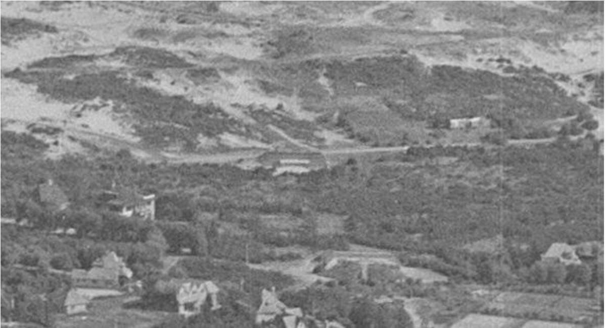
Figuur 11 Oblieke luchtfoto 4 augustus 1945 met centraal in beeld de rechtopstaande structuur (bron: NARA)
