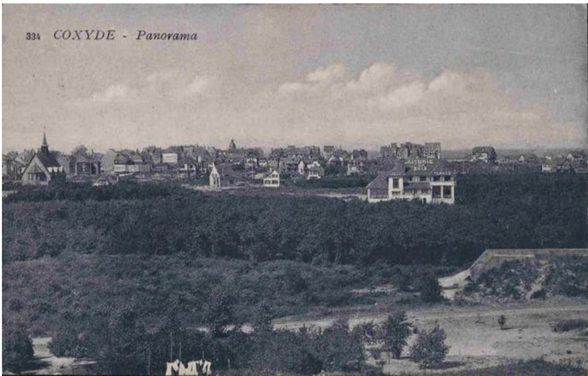
Figuur 8 Zicht vanop de Hoge Blekker met vooraan rechts te betonnen muren en aarden wal (bron: Westhoek Verbeeldt)
