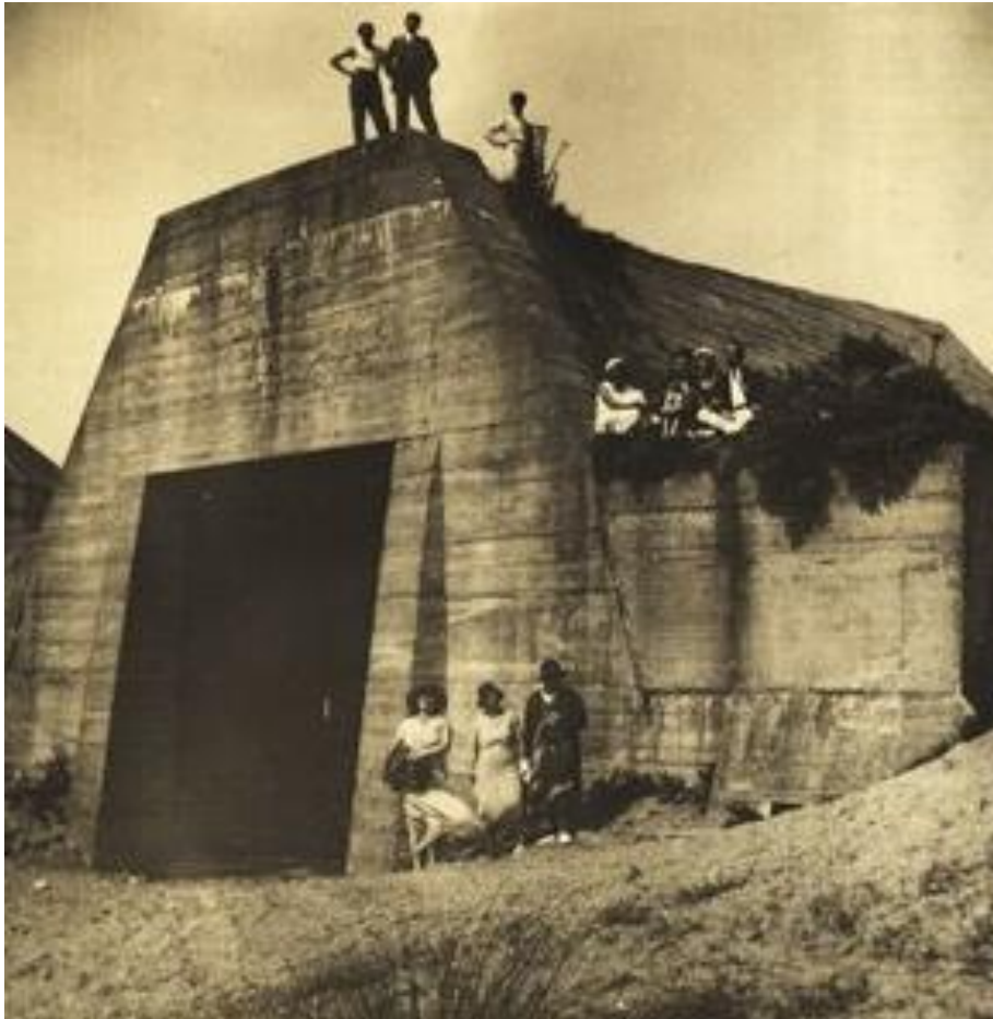
Figuur 6: Foto type bunker Vossenstraat (bron: Westhoek Verbeeldt)
