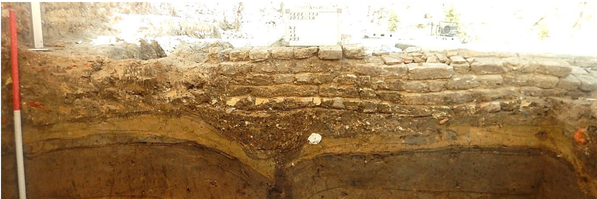
Figuur 8: Fundering in gele baksteen van de gemeenschappelijke muur tussen Huis 1 en Huis 4 met onderliggend een deel van de leemvloeren en lagen van de oudere woonfasen (H1, kwadrant 3, profiel P55). Foto: Monument-Vandekerckhove.
