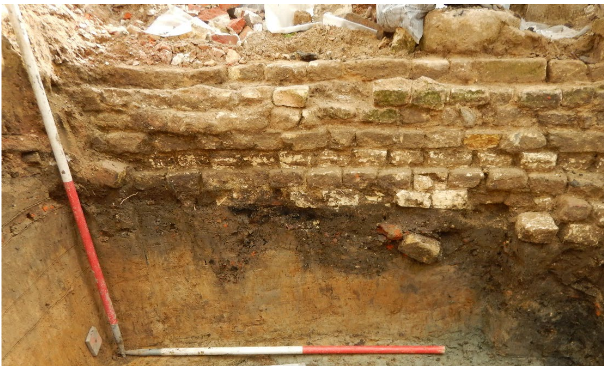
Figuur 7: Fundering in gele baksteen van Huis 4 (H4, kwadrant1, profiel P88). Foto: Monument-Vandekerckhove.
