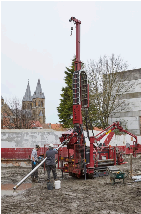
Figuur 1: De door Geosonda Environment NV ingezette Aqualock 100 mm op het perceel Torhoutsesteenweg 133, 8400 Oostende, © agentschap Onroerend Erfgoed, foto: Kris Vandevorst, 08/04/2022.
