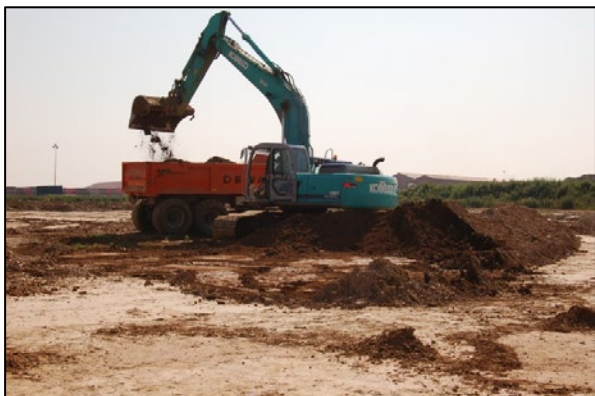
FIG. 7 Het afgraven van de bouwvoor.
