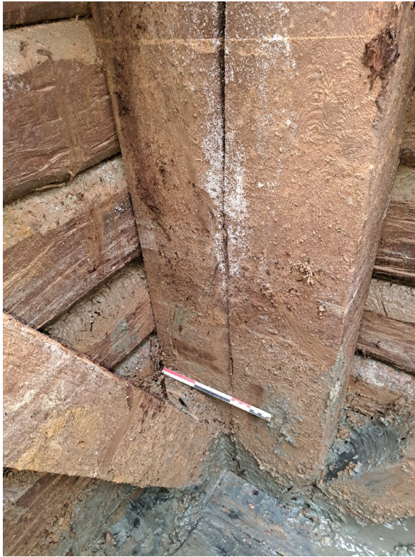
Figuur 19: Detail van de zuidwestelijke hoek en detail van de achterwand. Foto: agentschap Onroerend Erfgoed.
