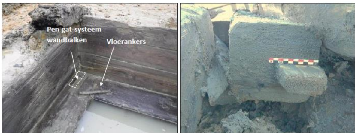
Figuur 4: Zicht op een de pen-en-gatverbinding van een Duitse schuilplaats op de site van Ieper Bellewaarde (Vermeulen, Baeyens 2023).
