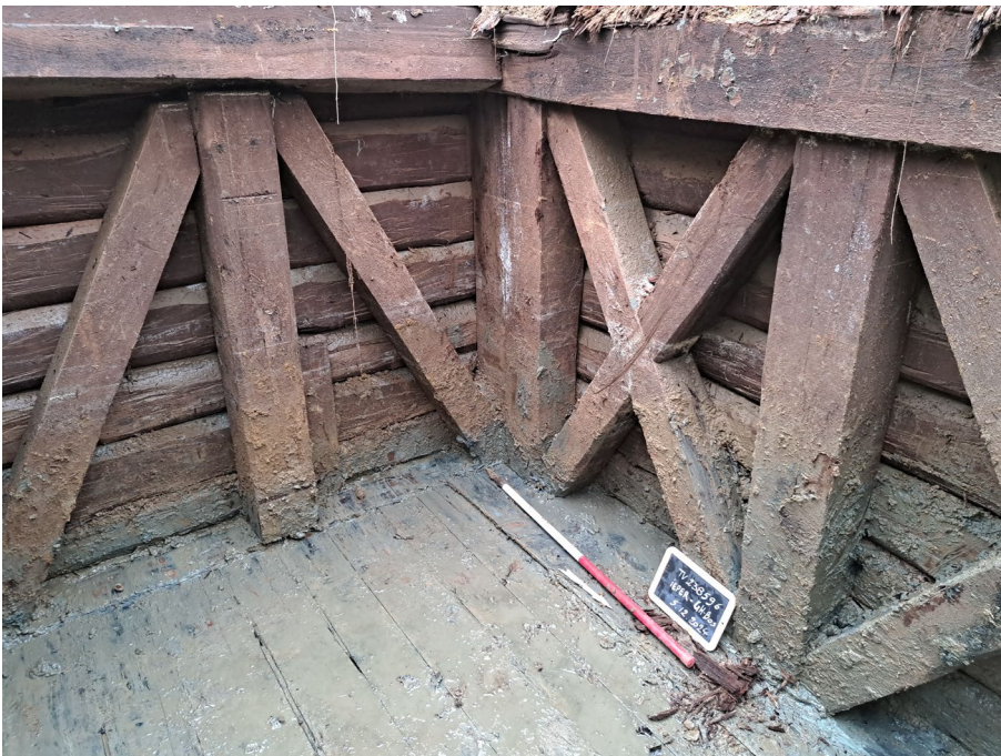
Figuur 21: Op deze foto (hoek zuidelijke-westelijke wand) is duidelijk te zien dat de vloerplanken eindigen tegen de stijlvoetplaat, waarop de verticale balken en schoren rusten. Foto: agentschap Onroerend Erfgoed.
