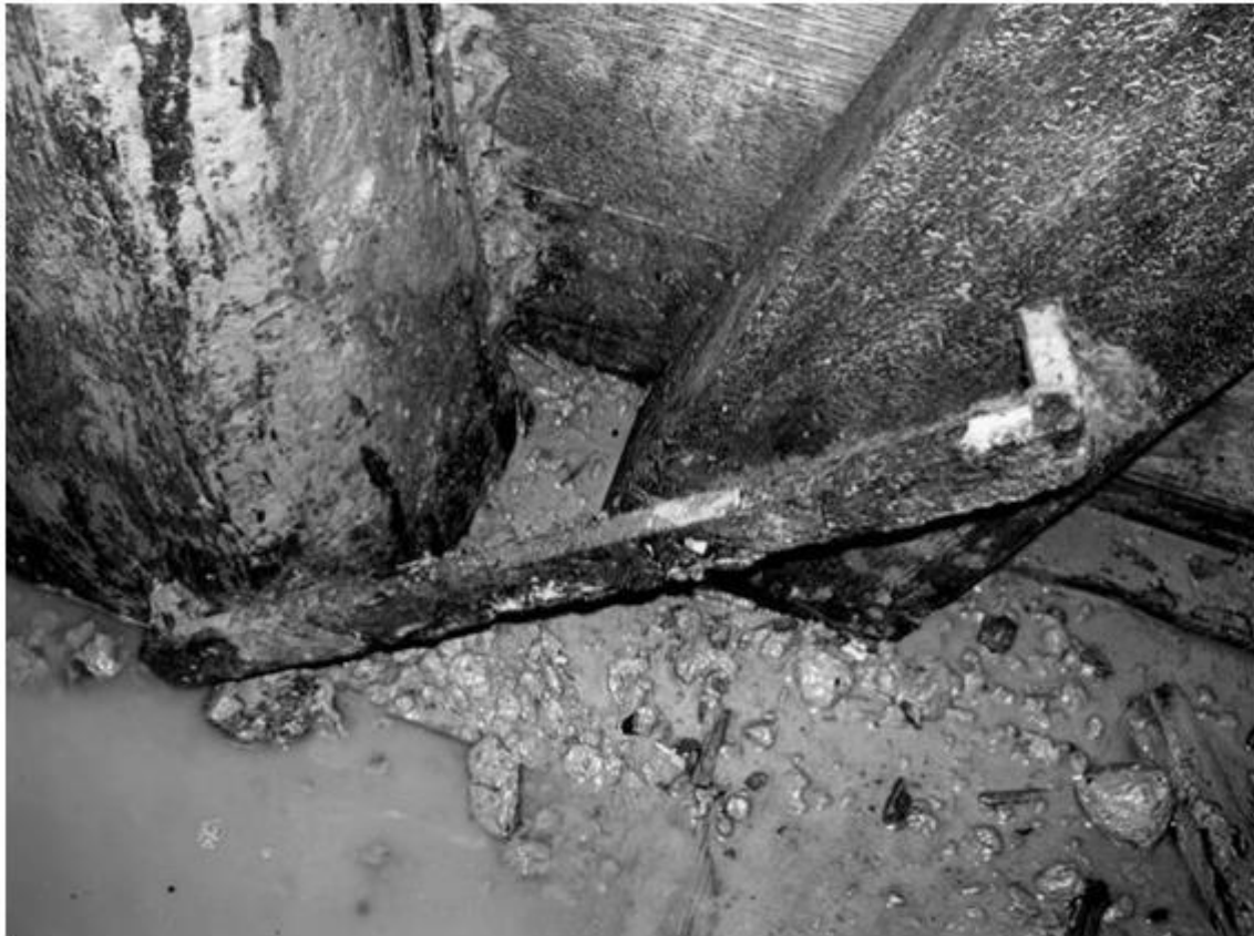
Figuur 11: Een ijzeren anker in de Duitse schuilplaats van Mesen. Deze hield de hoekpijlers stevig vast aan andere steunbalken om instortingsgevaar te voorkomen (© Geschiedkundig Museum Mesen).
