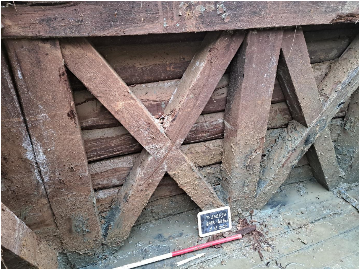
Figuur 7: Zicht op de lange westzijde, waar tot tweemaal toe gekruiste voetschoren werden aangewend (© Sam De Decker).
