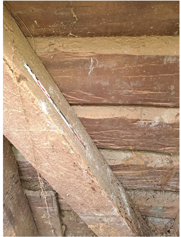
Figuur 20: detail van de achterwand met afgeschuinde planken. Foto: agentschap Onroerend Erfgoed.
