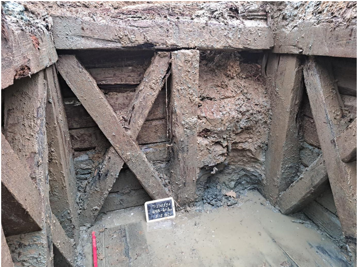
Figuur 6: Zicht op de korte noordelijke zijde. Links van de toegang werden gekruiste voetschoren gebruikt (© Sam De Decker).
