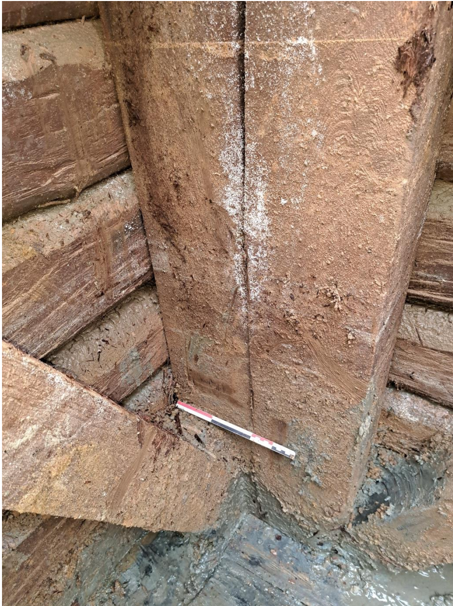
Figuur 10: Op iedere hoek staan twee hoekpalen waarmee de draagkracht wordt verhoogd (© Sam De Decker).
