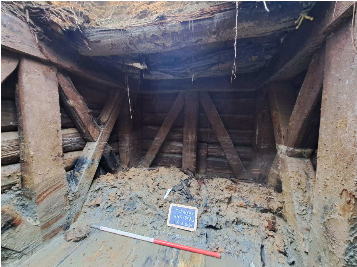
Figuur 16: Binnenzicht (richting zuiden) van de schuilplaats met een deels bewaard plafond. Foto: agentschap Onroerend Erfgoed.
