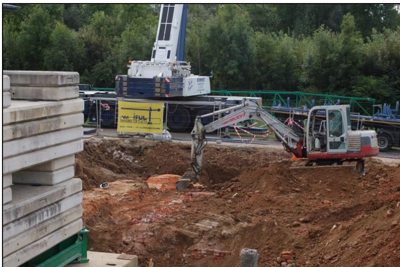
FIG. 18 Het vrijleggen van de bakstenen muur.
