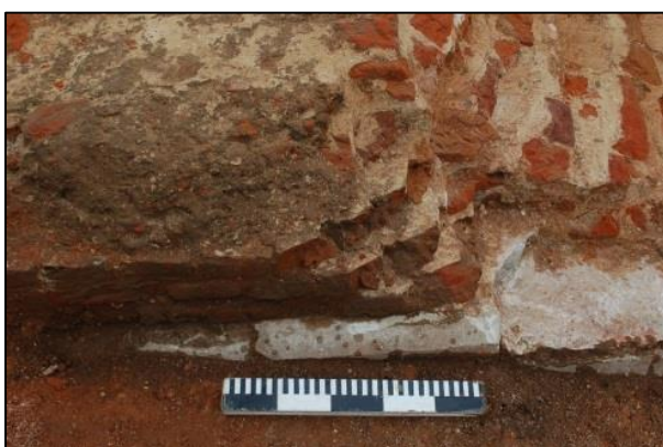
FIG. 29 De bakstenenparamentmuur verder opgebouwd op de kalkstenen muur.
