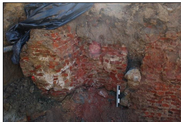
FIG. 35 De ondiep gefundeerde bakstenen muur in de hoek van het zuid- en oostprofiel.
