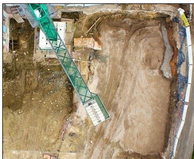
FIG. 21 Luchtfoto met zicht op de werkput en de aanwezige sporen tijdens de tweede registratie. (© Arial Media)
