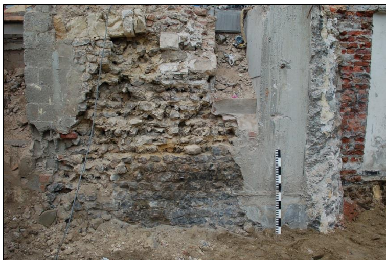
FIG. 33 De restanten van een fundering in silexblokken in werkput 4.
