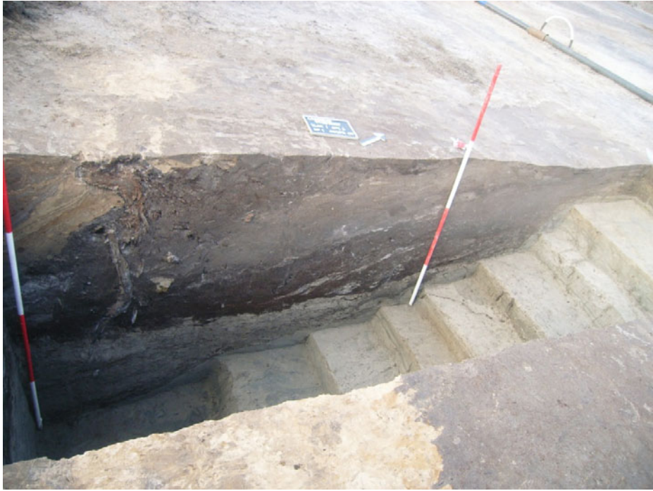
Fig. 24 Westprofiel van de coupe door het noordelijk deel van de walgracht.
