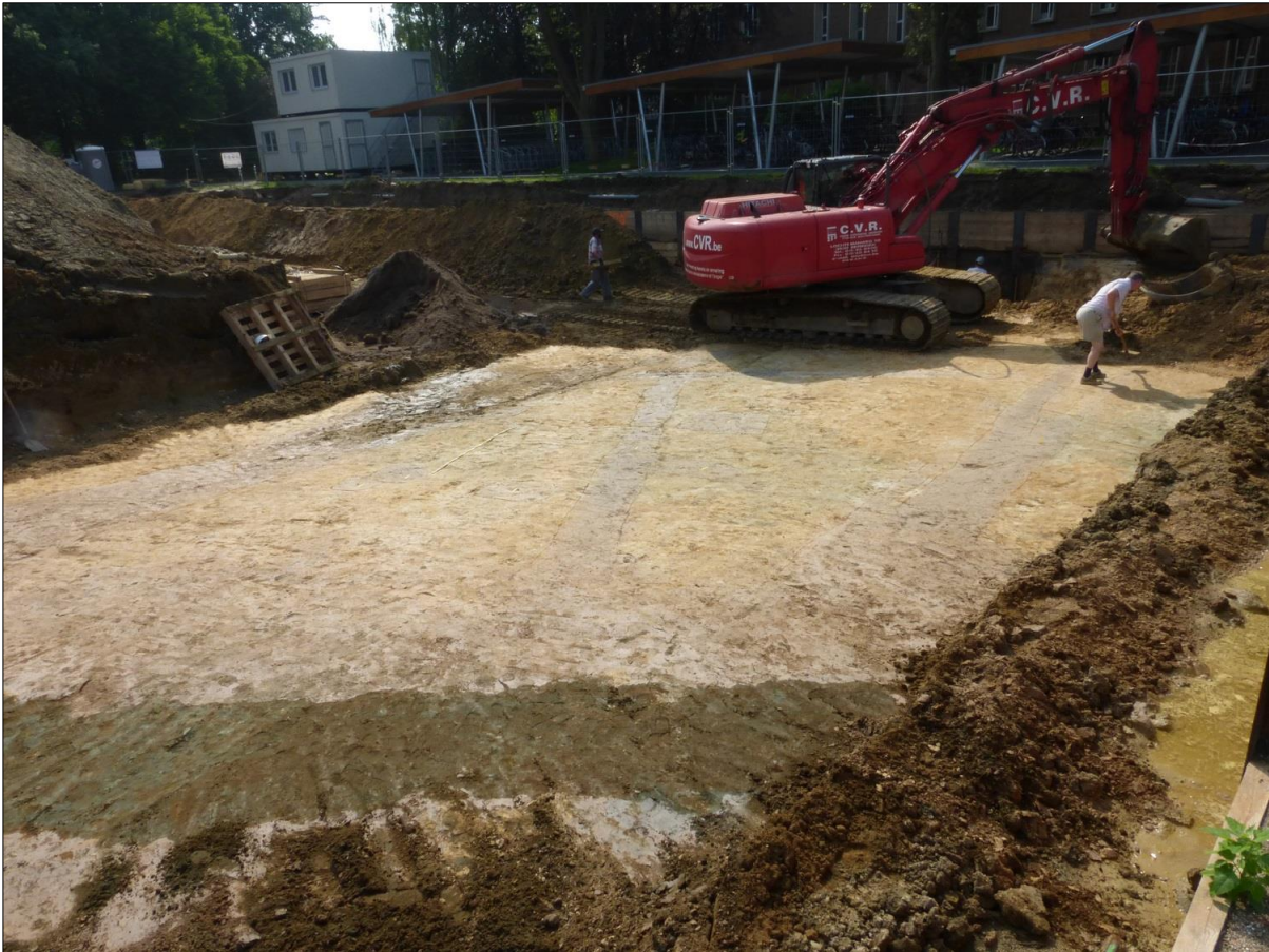
Fig. 7. Zicht op hetzelfde zuidwestelijk deel van de bouwput, rond sporen 1 t.e.m. 17, gefotografeerd op 7 juni 2016 vanop de westelijke rand van de bouwput. De diepere sleuf voor de damwanden was reeds voor de aanvang van het archeologisch onderzoek gegraven aan de zuidzijde van de bouwput (op de foto achter de kraan). Aan de westzijde van de bouwput (rechts op foto) kon het archeologisch onderzoek echter uitgevoerd worden voor deze uitgraving ook daar plaatsvond.
