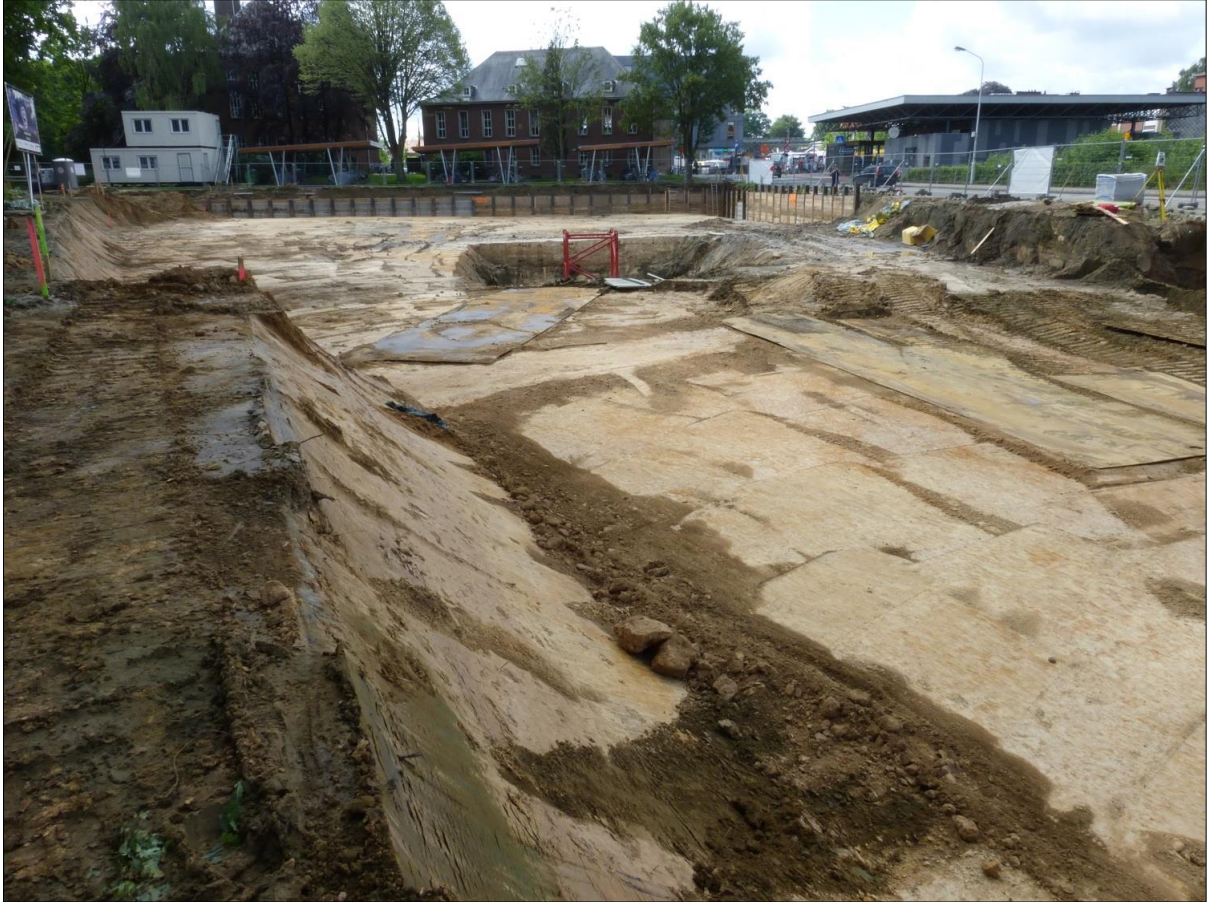
Fig. 4. Zicht vanuit het noorden op de bouwput na het volledig afgraven van fase 1, gefotografeerd vanop de oostelijke wand van de bouwput. Centraal op de foto is de diepere put voor een toekomstige liftkoker zichtbaar (met rode metaalstructuur), die reeds voor de aanvang van het archeologisch onderzoek was uitgegraven.
