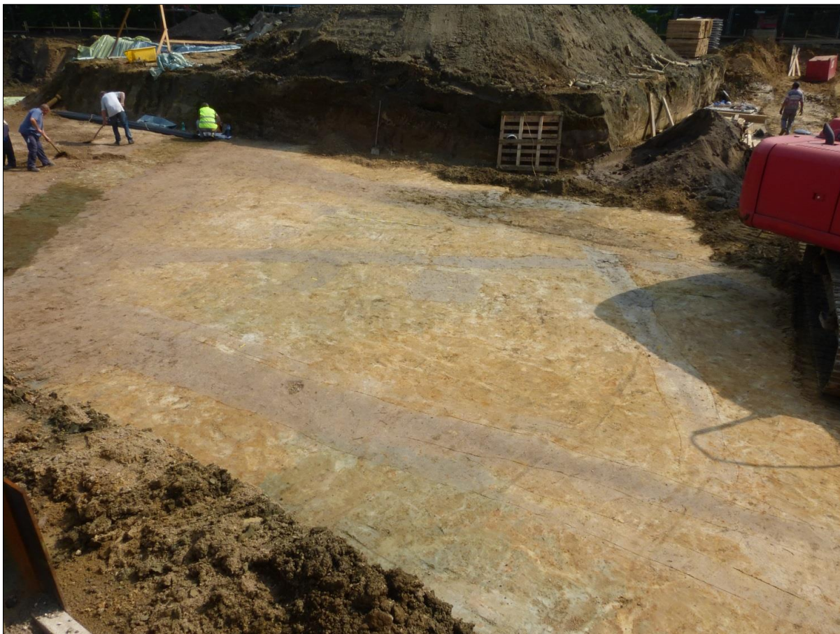
Fig. 6. Zicht op het zuidwestelijk deel van de bouwput, rond sporen 1 t.e.m. 17, gefotografeerd op 7 juni 2016 vanop de zuidwestelijke rand van de bouwput. Het volledige vlak werd hier opgeschaafd. Het talud op de achtergrond werd enkele dagen later tot op hetzelfde niveau afgegraven.
