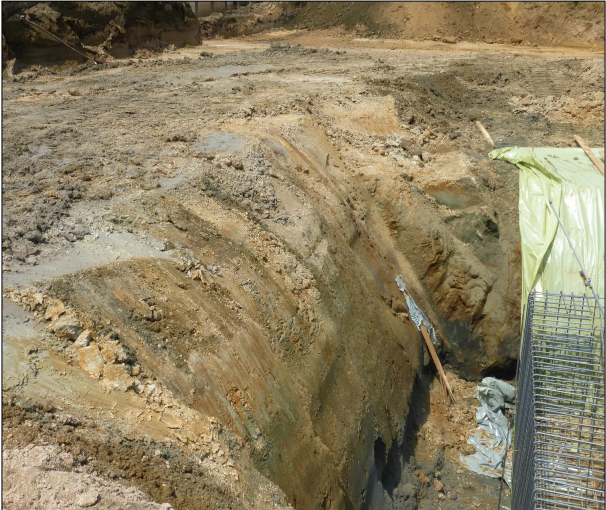
Fig. 18. Wand van een dieper uitgegraven zone.
