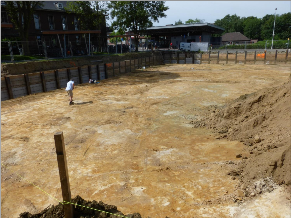
Fig. 9. Zicht op zuidelijk deel van de bouwput, gefotografeerd op 10 juni 2016 vanop de oostelijke rand van de bouwput. Hier werden enkel de (mogelijke) sporen en hun onmiddellijke omgeving opgeschaafd, met uitzondering van een centrale plek rond sporen 29 t.e.m. 41 en de zuidwestelijke hoek zoals zichtbaar in figuren 6 en 7. Rechts op de foto is de rand van het talud zichtbaar dat op dat moment verder afgegraven werd.
