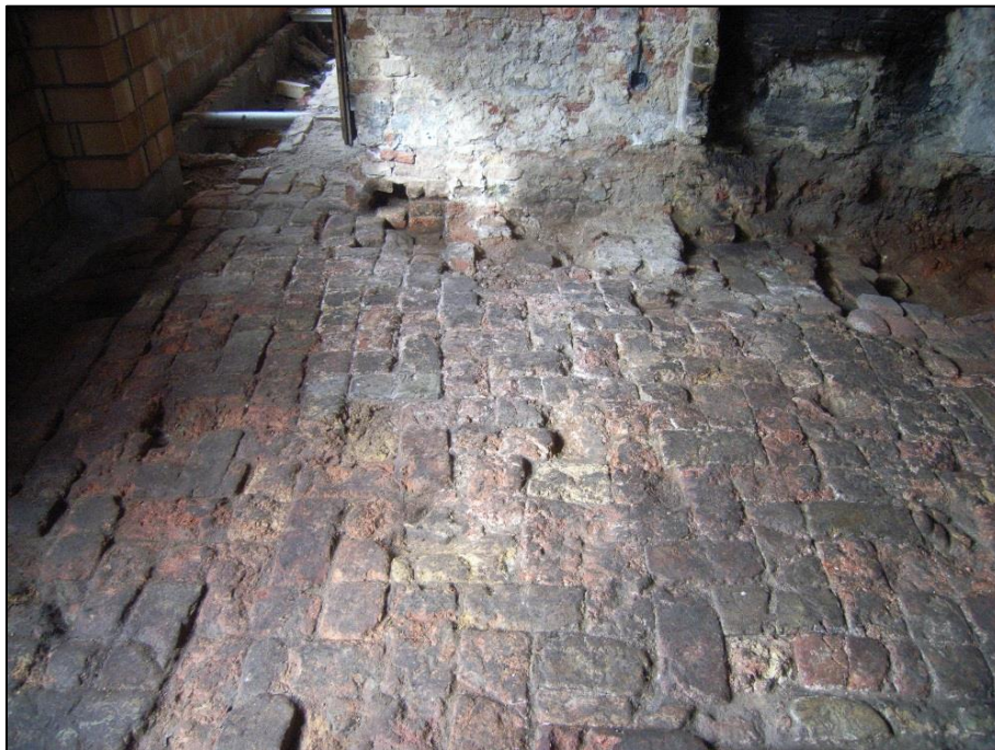
Fig. 8 Een gedeelte van de vloer is in keper- of visgraatverband gelegd.
