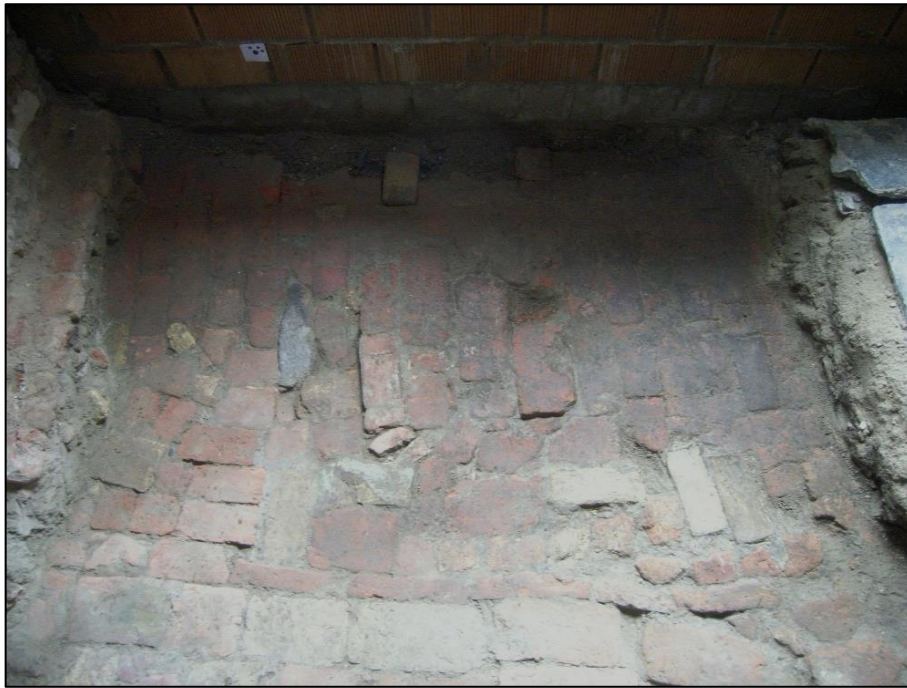
Fig. 12 Compartiment tegen de zuidmuur aan. Het is een allegaartje van allerlei bakstenen, baksteenbrokken en tegels.
