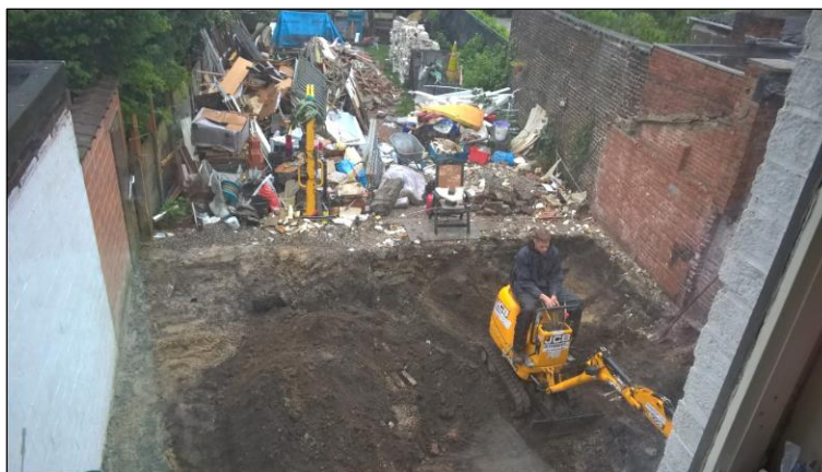
Fig. 10: De graafwerken voor het bouwen van de keuken (foto: W. Bloemen)
