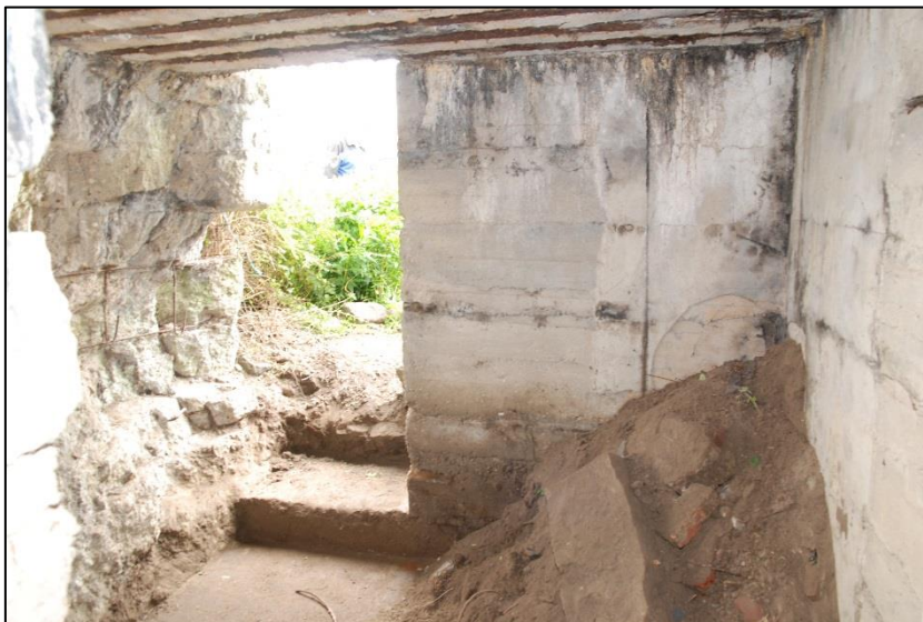
Fig. 9 In het beton zijn plankjes verwerkt om interieurelementen vast te maken. Bij de poging tot sloop is de wapening tevoorschijn gekomen.
