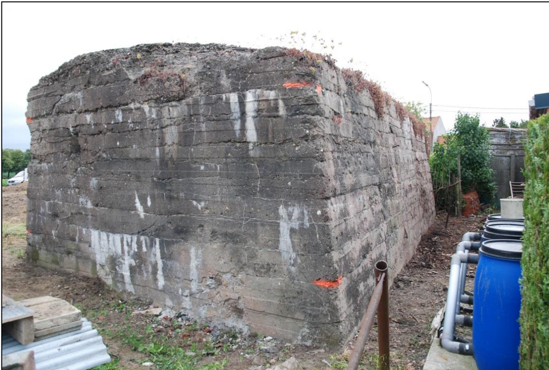
Fig. 7 De bunker vanuit het zuidwesten. Links bovenaan, nabij de de hoek is de opening van de ventilatieschacht te zien.
