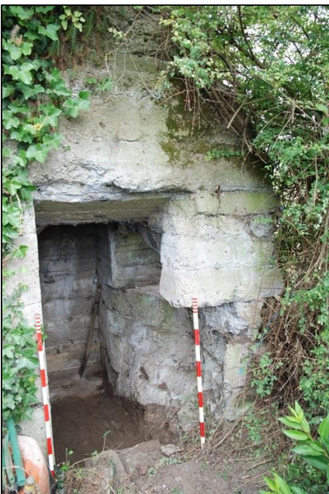
Fig. 14 Beschadiging aan de ingang en op de noordoosthoek (met klimop overwoekerd).
