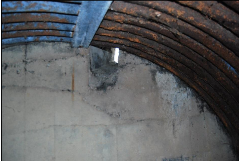
Fig. 12 Schuin doorheen de oostmuur loopt een ventilatiepijp.
