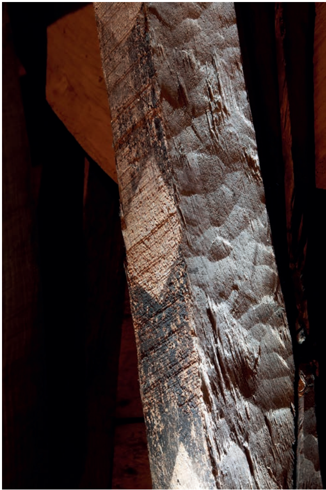
FIG. 10 Keper in de dakkap van het koor met bewerkingsporen van een raamzaag en dissel.
