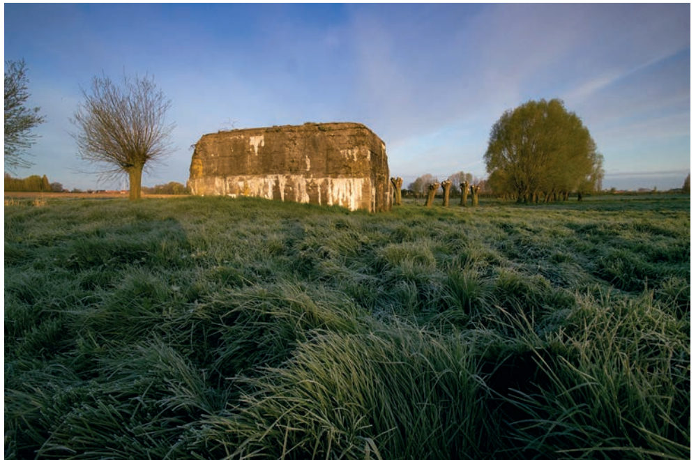
FIG. 18 Bunker met hoge contextwaarde in een weide langs de Groenestraat te Zonnebeke (RG3)(Michael Sheil). High-value bunker in a meadow along the Groenestraat in Zonnebeke (RG3)(Michael Sheil).
