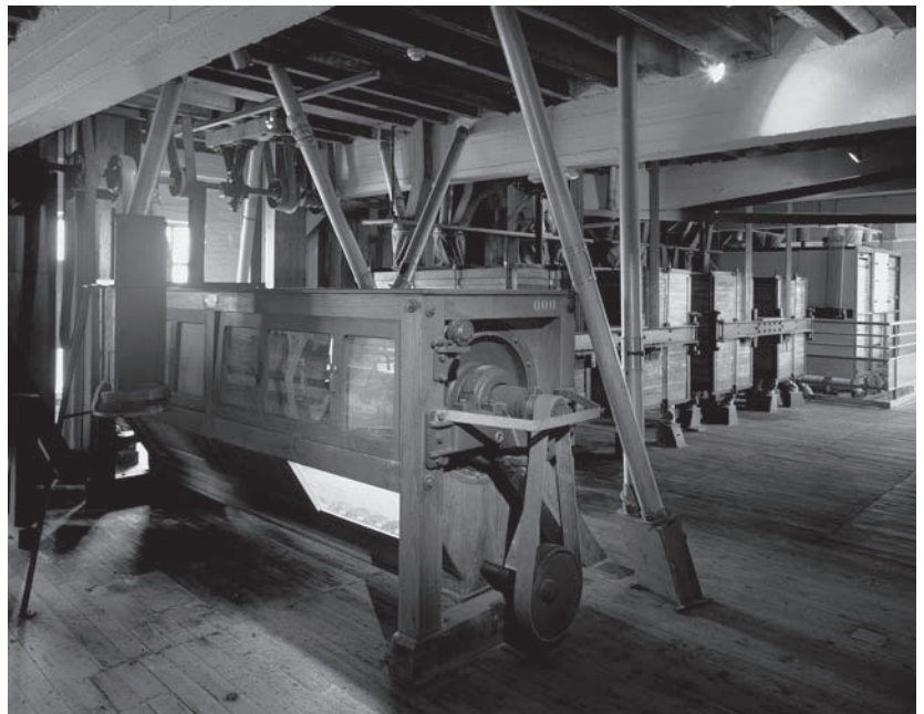
39 Veiligheidsbuil op de vierde verdieping. Boulter on the fourth floor.
