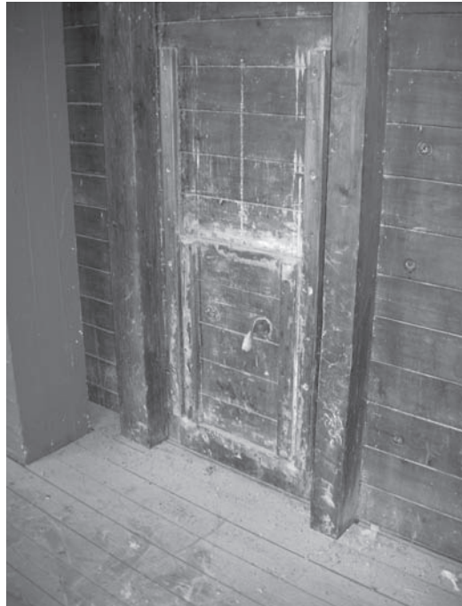
41 Eén van de vier bloemsilo's. Flour silo.
