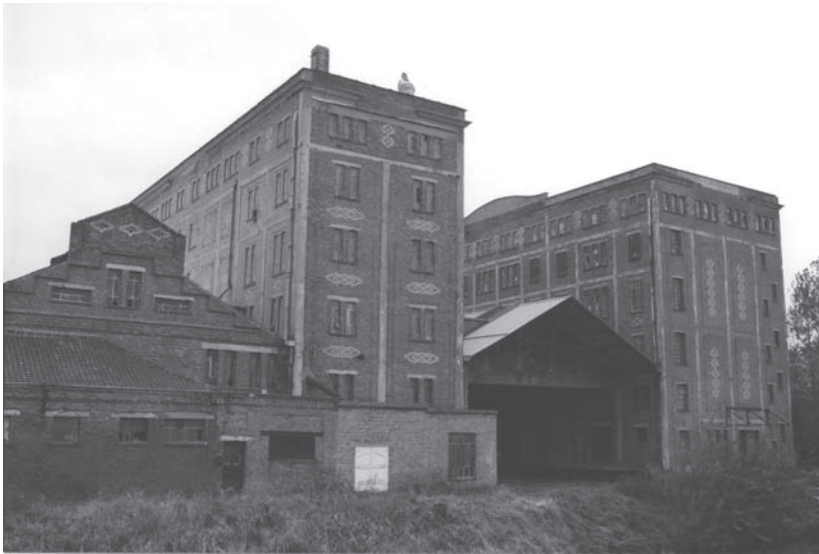
13 De twee fabriekstorens (noordzijde) met links het machinegebouw omstreeks 1994. (Coll. R-O Vlaanderen – Industrieel erfgoed) The two mill towers (north side). The engine room on the left, 1994.
