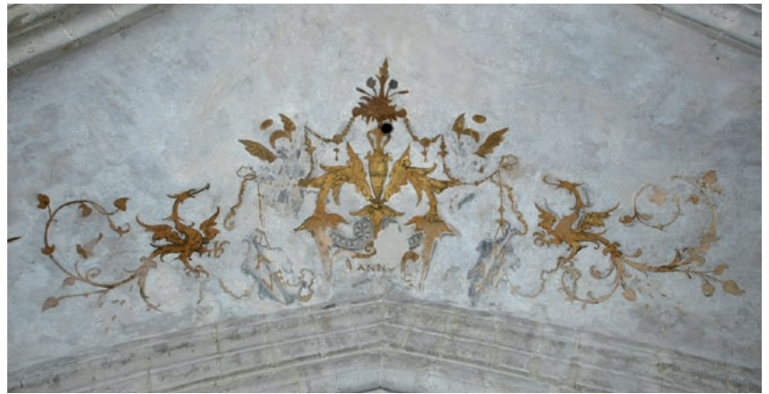
FIG. 21 a: smal gewelfvlak van de vijfde travee na restauratie. b: de staart van de draak is uitgewerkt in een sierlijk rankwerkmotief. a: small vault surface in the fifth bay, after restoration treatment. b: the tail of the dragon is depicted as an elegant foliated ornament.
