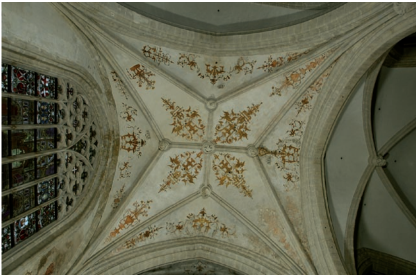
FIG. 10 Gewelfschilderingen van de vijfde travee van de meest noordelijke zijbeuk na restauratie.
