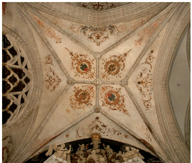
FIG. 24 Gewelvschilderingen van de zesde travee na restauratie, met de wapenschilden van Burgos en van het Spaanse koninkrijk. Vault paintings in the sixth bay after restoration treatment. These show the coats of arms of Burgos and the Spanish kingdom.
