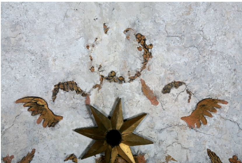
FIG. 11 De verluchtigingsgaten werden in een latere periode aan het gezicht onttrokken met vergulde sterren.
