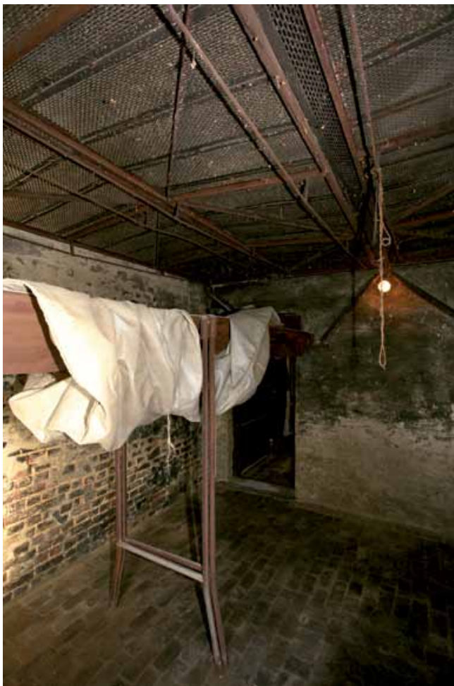
FIG. 30 IJzeren rek om hopzakken aan op te hangen in de hopast Brutsaert in Watou.
