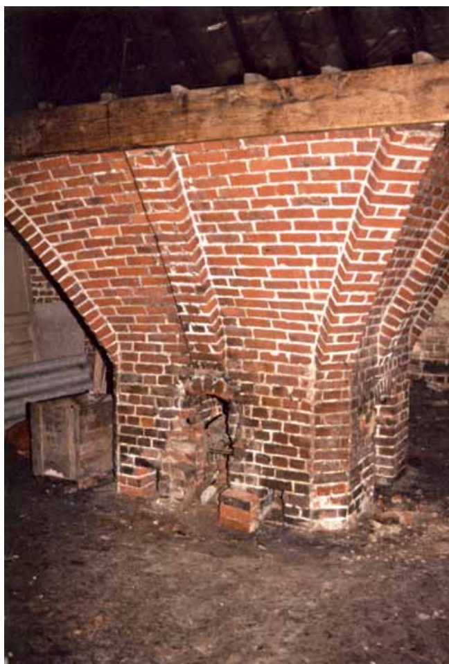
FIG. 7 Eestoven met tremelvormige hel in de hopast De Schepper in Erembodegem (Coll. R. De Meerleer, Burst). Drying kiln with funnel-shaped hell, oast house De Schepper in Erembodegem (Coll. R. De Meerleer, Burst).
