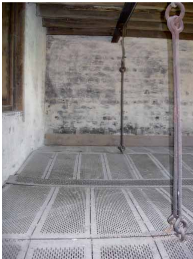
FIG. 29 Ophang- en katrolsysteem om de vloerpanelen te lichten in de hopast Brutsaert in Watou.
