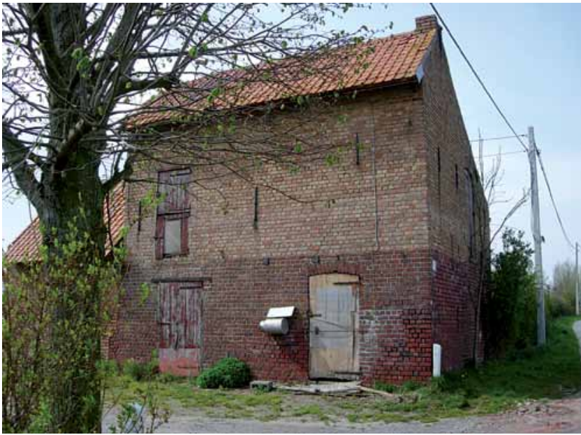
FIG. 32 De hopast Rosseeuw in Poperinge. Een voorbeeld van een ast met drie boven elkaar geplaatste eestvloeren. Hop oast house Rosseeuw in Poperinge. An example of an oast house with three stacked drying floors.
