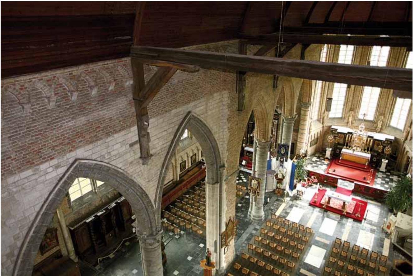
FIG. 3 Binnenzicht in het middenkoor, met zicht op de noordelijke langsmuur (© VIOE, K. Vandevorst). Interior view of the central choir, facing the northern wall (© VIOE, K. Vandevorst).
