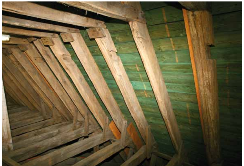
FIG. 5 Dakkap boven de westelijke traveeën van het middenkoor met een afwisseling tussen sporen met een vierkante sectie en sporen met een rechthoekige sectie. Bemerkt de open inkavelingen op de sporen met vierkante sectie (© VIOE, K. Vandevorst). Roof above the two westernmost bays of the central choir, with a conspicuous alternation between rafters with a squared and a rectangular cross-section. The squared rafters all have open joints (© VIOE, K. Vandevorst).
