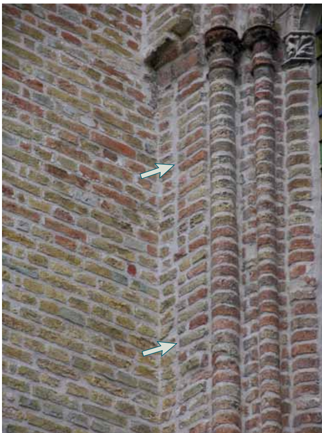
FIG. 17 Derde travee van het zuidkoor met een bouwnaad tussen venster en westelijke steunbeer.
