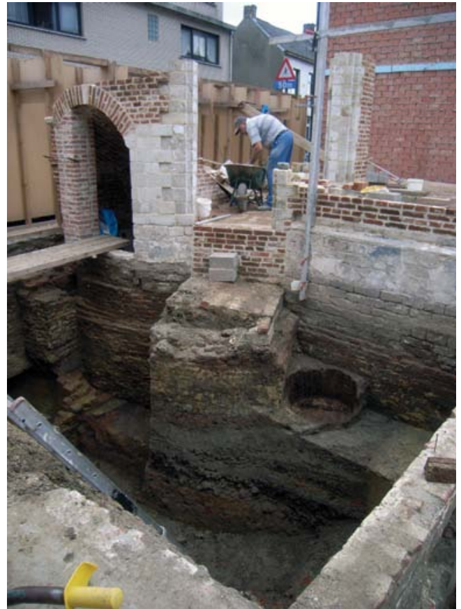
FIG. 18 Zicht op de oostmuur en het torengedeelte met de toegang tot de kelder. View of the eastern wall and tower section with the entrance to the basement.
