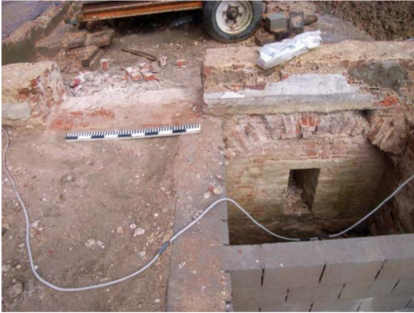
FIG. 24 De noordmuur van de ruimte tussen de kelder muur en de oorspronkelijke oostmuur werd voorzien van een lichtopening. The northern wall of the compartment between the basement and the original eastern wall of the building was fitted with a loophole.
