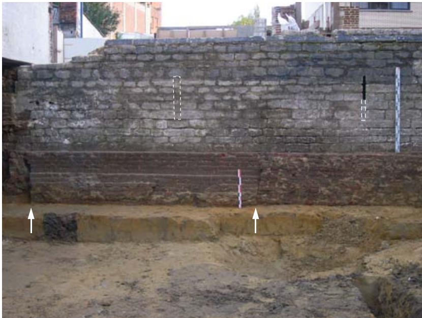
FIG. 20 Bouwnaad in het funderingswerk van de noordmuur van het Hof van Peene, met aanduiding van het volledig en deels dichtgemetste lichtgat. Seam in the brick foundation of the northern wall of the Hof van Peene, with indication of the completely and partially infilled loopholes.
