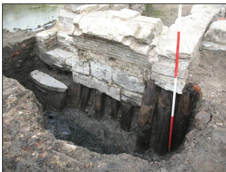
Figuur 43 fundering van de brugconstructie
