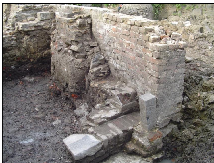
Figuur 44 zicht op de kademuur
