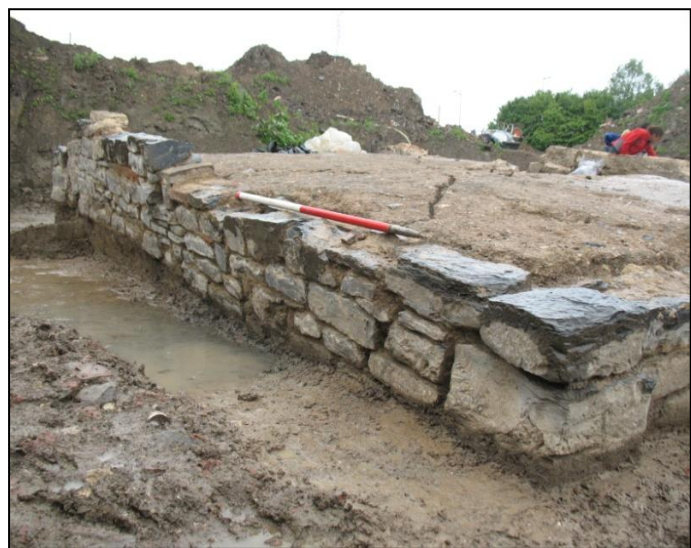
Figuur 39 verzakkingen aan het bijgebouw
