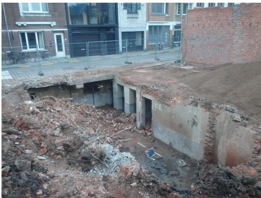
Figuur 21: Centrale kelder. Foto richting zuiden.
