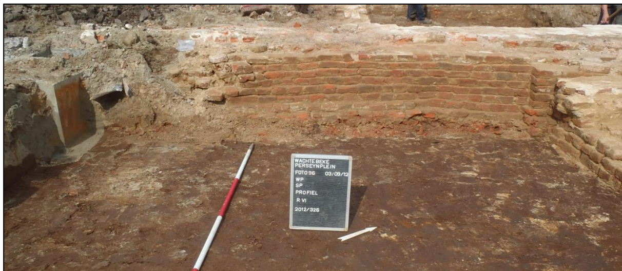
Figuur 45: steunbeer S.3.060 aan de zuidoostelijke zijde van de fundering van het hoofdgebouw.
