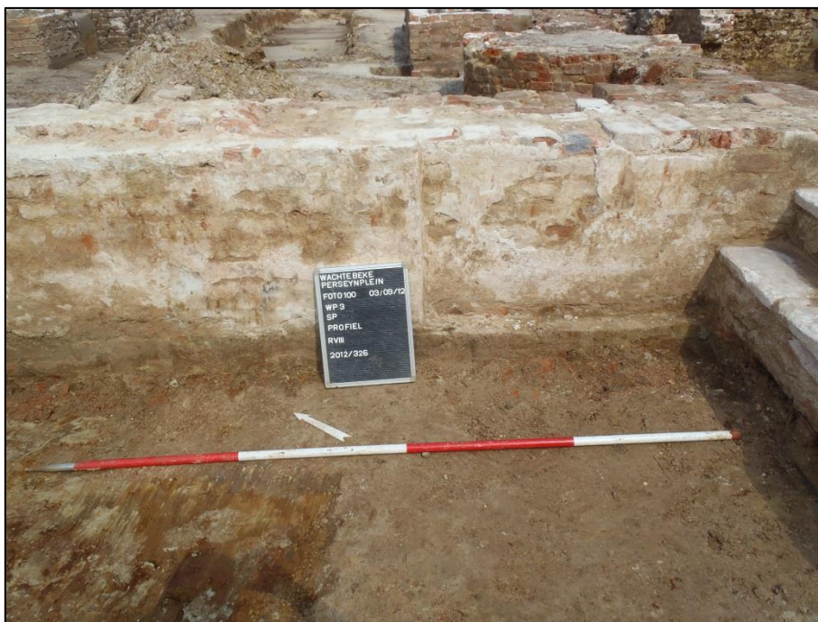
Figuur 36: bepleistering van de 15e-16e eeuwse kelder muur, met net onder deze bepleistering de aanzet van een vloerniveau (links).
