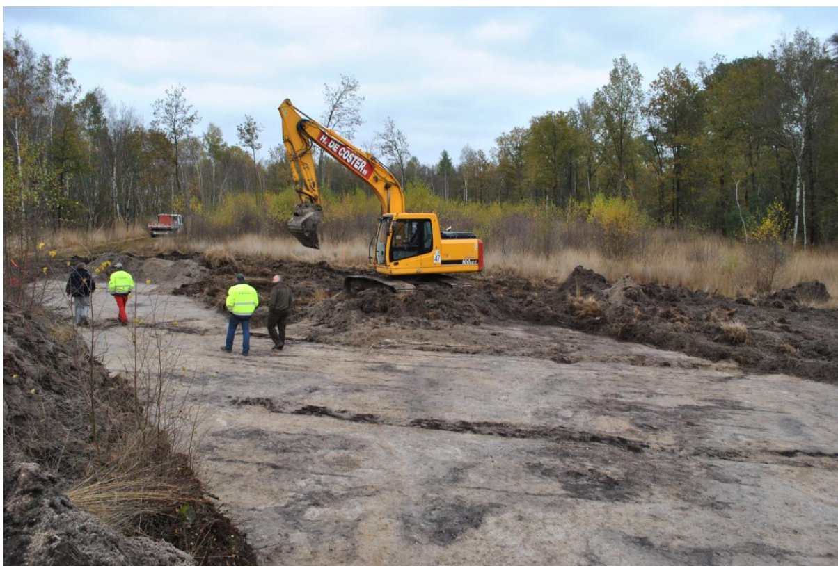
Fig. 6: De aanleg van het vlak.
