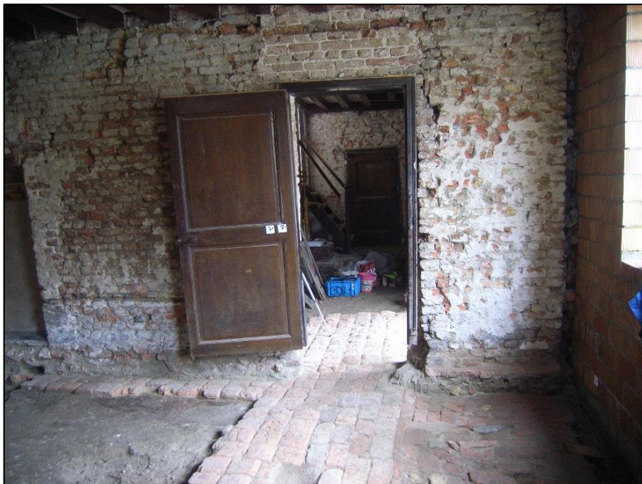
Fig. 13 Zicht op de tegelvloer vanuit het westen. De tussenmuur is op de oude vloer neergezet.
