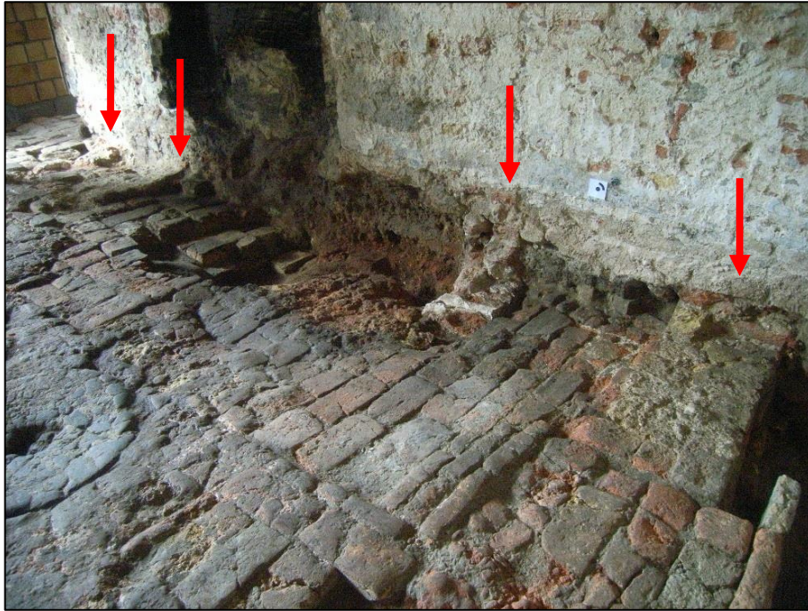
Fig. 9 Zicht op de restanten van vier schouwvallen, die tot twee opeenvolgende schouwen behoren.
