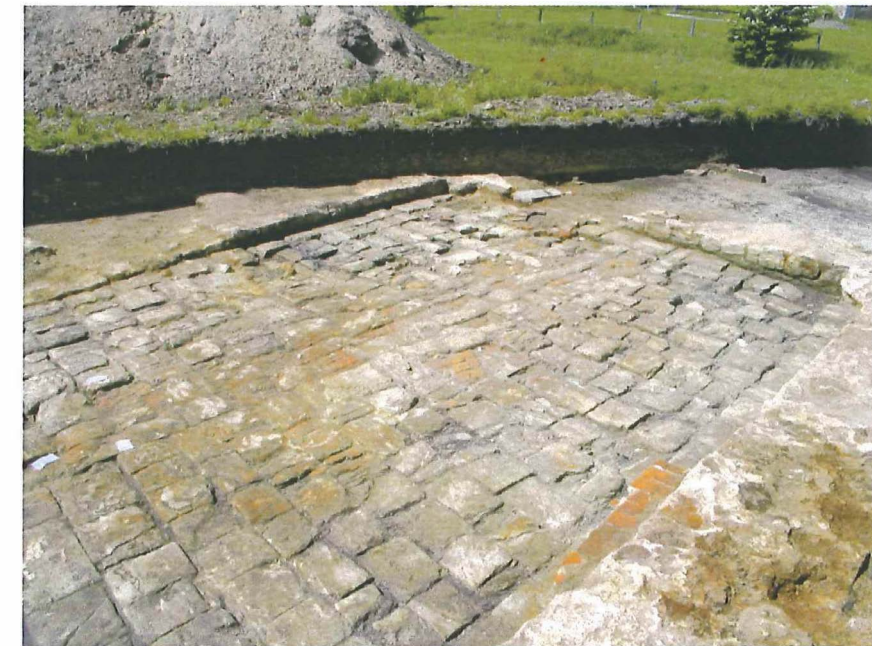
Foto 4.12: Zicht op de verschillende herstellingen in de oude kalkstenen vloer (Foto 05-KUHE-0701).
