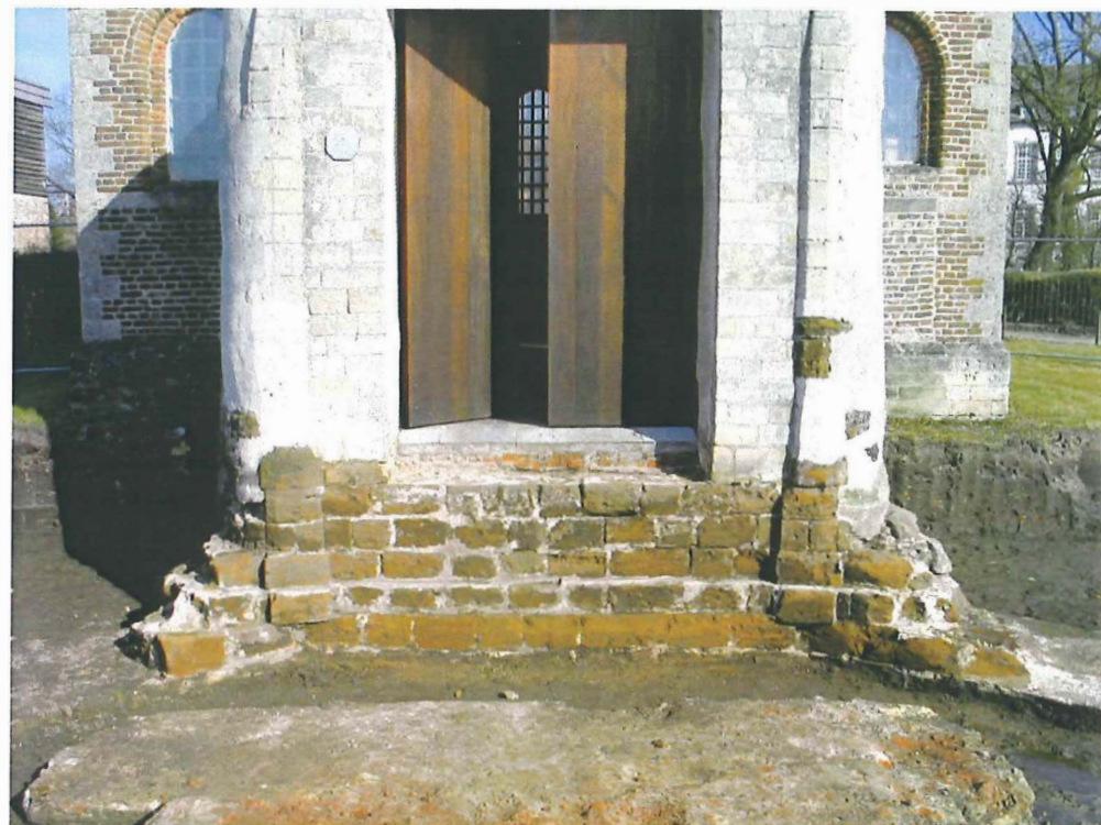
Foto 4.62: Zicht op het bewaard stuk opgaand muurwerk (Foto 05-KUHE-0413).
