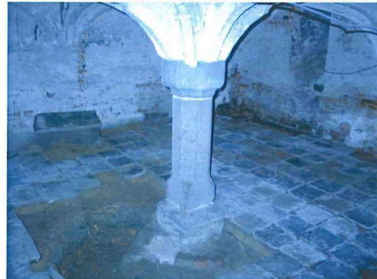
Foto 4.37: Zicht op de natuurstenen vloer in de kelder (Foto 04-KUHE-1564).
