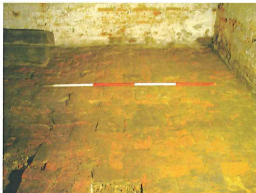
Foto 4.38: Zicht op de bakstenen vloer in elleboogverband in de kelder (Foto 04-KUHE-1671).
