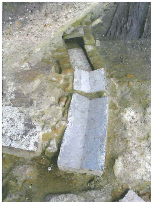
Foto 4.72: Afwateringsgootje doorheen de ijzerzandstenen muur (Foto 05-KUHE-1334).
