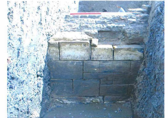
Foto 4.47: Detail van de fraai gezaagde mergelblokken van het grachtparament (Foto 04-KUHE-0548).
