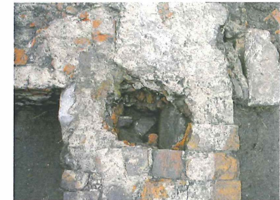
Foto 4.57: Gat in de funderingsmuur voor de scharnierbalk van de poort (Foto 04-KUHE-0344).
