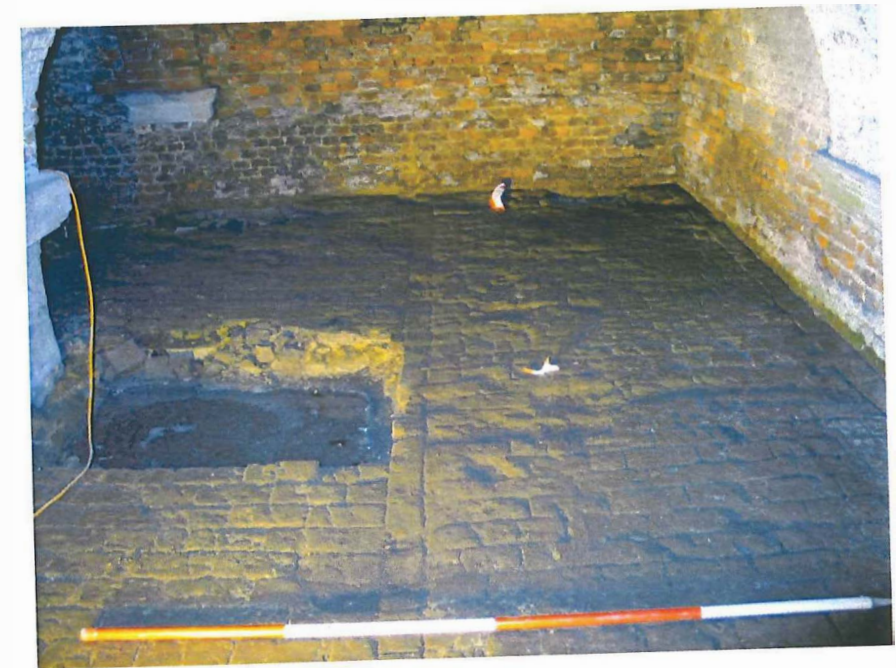
Foto 4.84: Bakstenen vloer in de kelders van de portierswoning (Foto 04-KUHE-1541).
