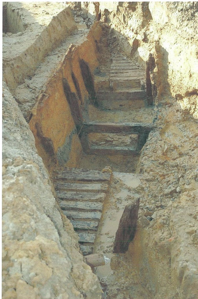
Fig. 22 Loopgraaf met A-frames en duck boards en telefoonlijnen
