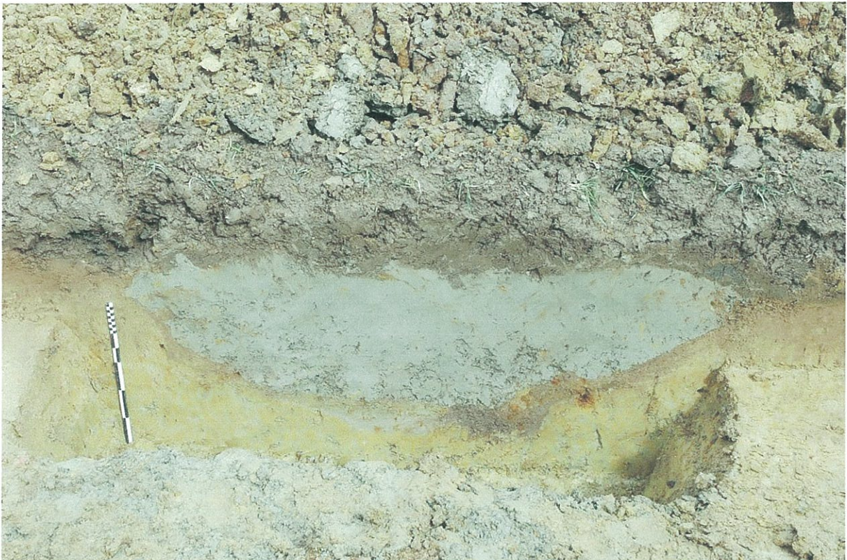
Fig. 14 Doorsnede van een loopgraaf, waarbij leperiaanse klei is angewend
