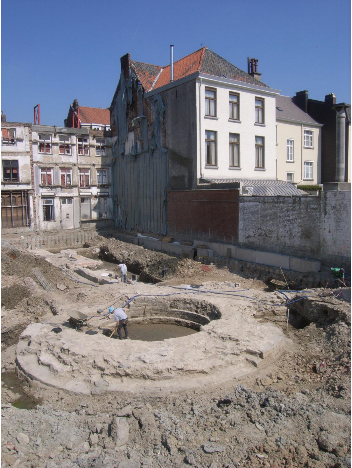
Figuur 40 Torenfundering
