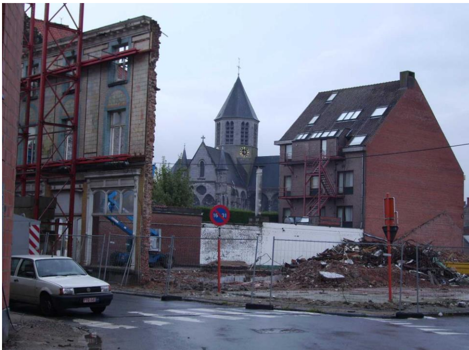
Figuur 4: Project 2007 - Zicht op de Pamelekerk. De voorgevel van het 19de eeuwse pand, Kasteelstraat 3, diende gevrijwaard te blijven bij de bouwwerken (beschermd stadsgezicht).
