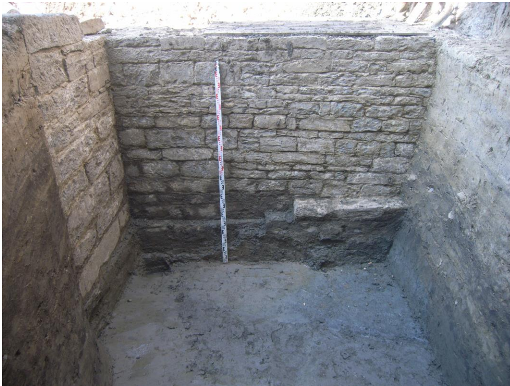
Figuur 39 Fundering kasteelmuur en ophogingspaketten
