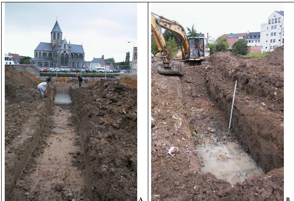
Figuur 16a Sleuf 5 - 16 b Sleuf 6 De situering van de kasteelgracht wordt onmiddellijk duidelijk bij de afgraving daar de puinrijke vulling onmiddellijk onderstroomt
