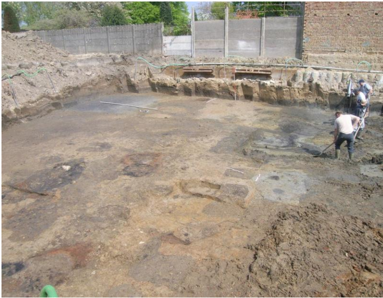
Figuur 13: Overzicht, noordelijk deel van de bouwput.
