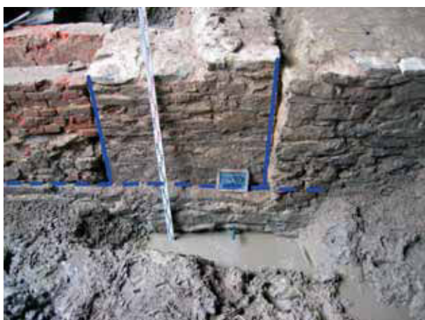
afb. 8: Rechthoekige pijler ter hoogte van de overgang van de eerste naar de tweede travee (Stad Gent, Dienst Stadsarcheologie)
