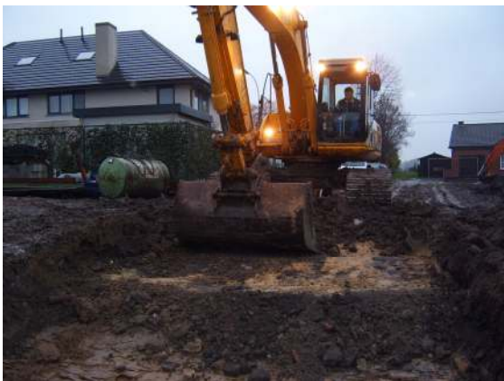
Fig. 21: Overzichtsfoto op de aanleg van de weggroef. Gezien de ligging van de weggroef werd deze als proefsleuf gebruikt.
