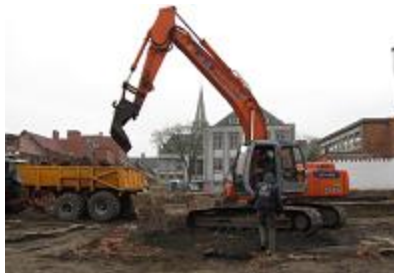
Afb 14 Aanleg van het vlak met directe afvoer van de grond
