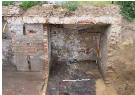
Afb 64 Zicht op het originele 16 de eeuwse tongewelf en de oostelijke kelder muur met onderaan rechts het 17 de eeuwse vloertje in een wildverband, met in de linkerhoek een veegpot. Het dunne afgebroken muurtje links vormde de scheiding tussen de Warandestraat 11 en 13 in de 19 de /20 ste eeuw.
