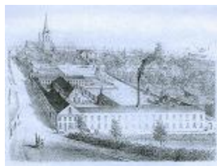
Afb 11 Gravure van de Glénisson-fabriek met aanduiding van het gebouw met trapgevel (ca. 1860) (bron: AdAK).
