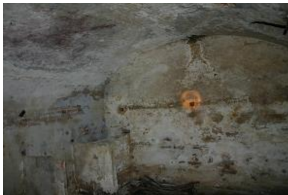
Afb 10 Zicht op het tongewelf van de kelder in de Warandestraat nr. 7 (bron: AdAK)
