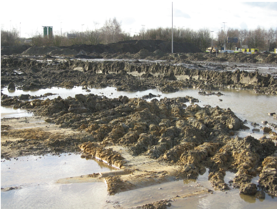
Figuur 11: Door het uitbreken van de verharde moederbodem is het bovenste pakket van de hoogstgelegen zone van het plangebied vernield
