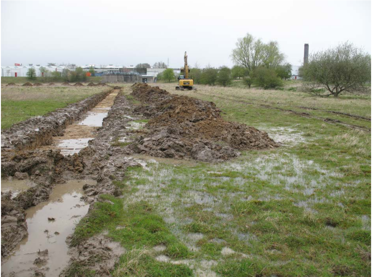
Figuur 17 : zicht vanuit zuidoosten op sleuf 4
