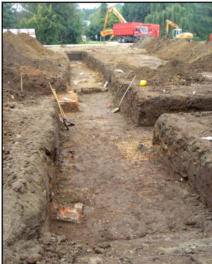
Figuur 4: Algemeen zicht vanuit het zuiden op sleuf I tijdens het onderzoek (© MVDK).
